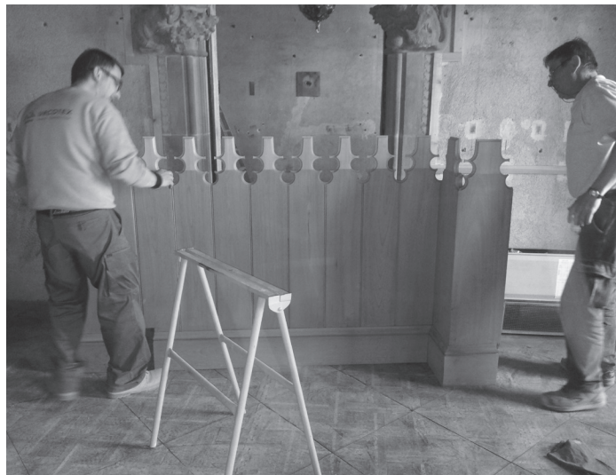
Restauración de los arrimaderos de madera e incorporación de faltantes (Archivo CIM).
