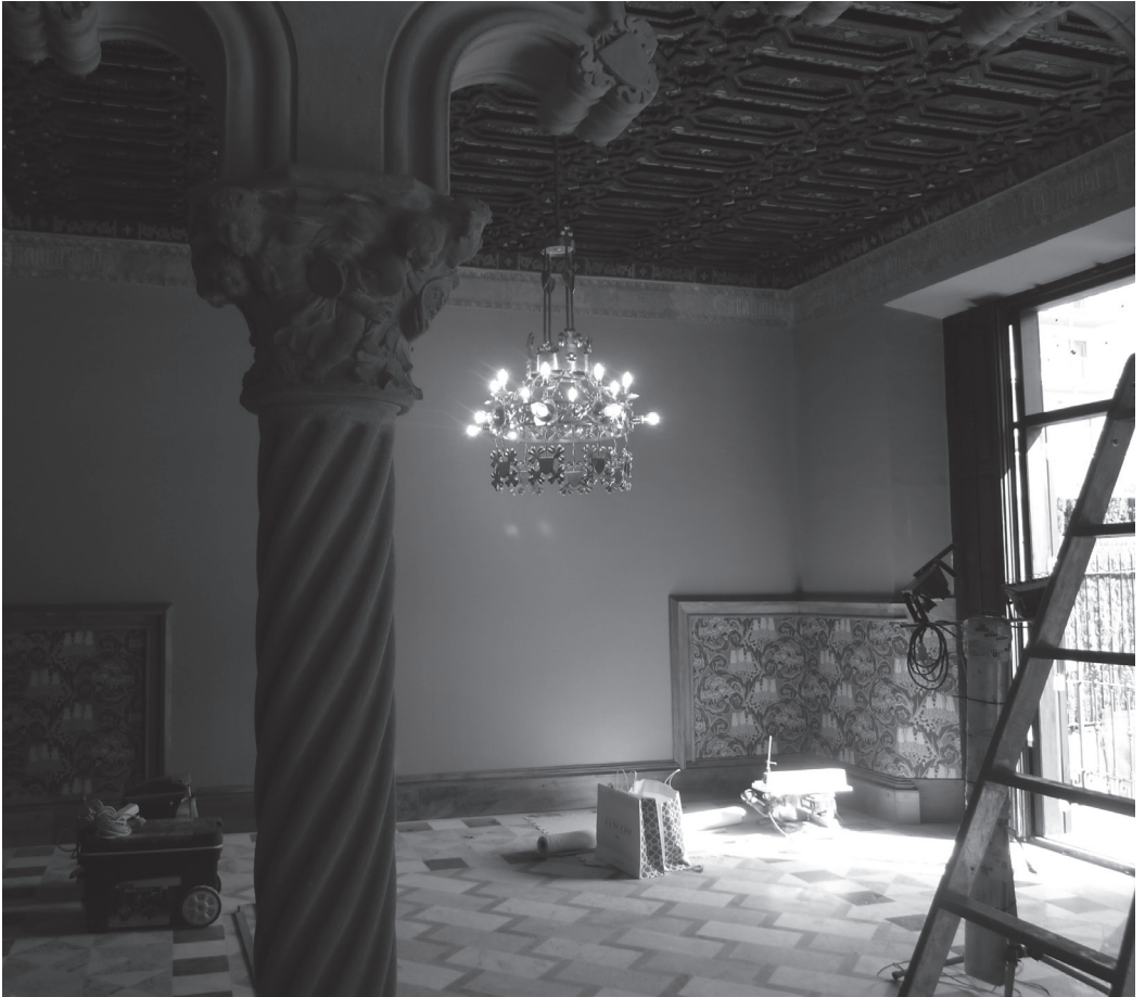
Sala de música; proceso avanzado de intervención (Archivo CIM).
