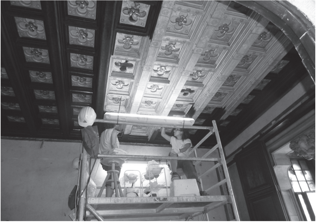
Dormitorio de Teresa Amatller; proceso de restauración del falso artesonado (Archivo CIM).
