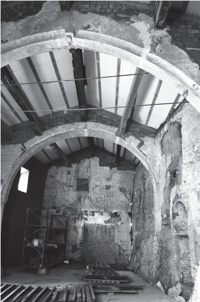
Estado inicial del interior hacia la cabecera, con la techumbre desmontada.
