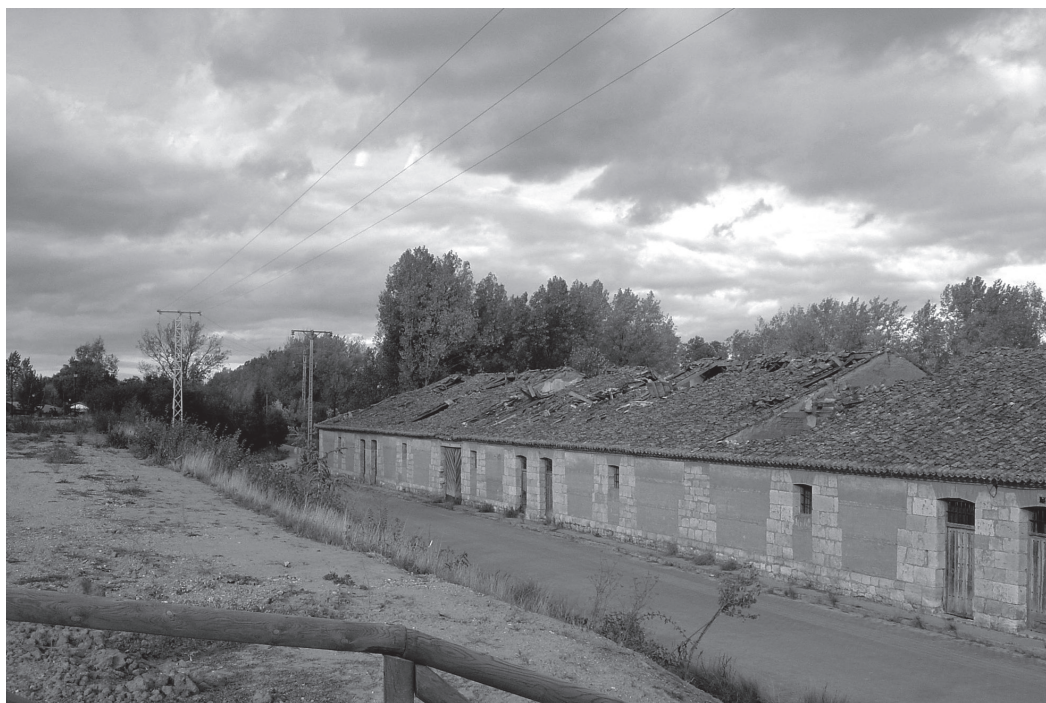
Almacenes II y III (imágenes superior e inferior) de la Dársena del Canal de Castilla en Medina de Rioseco (Valladolid).
