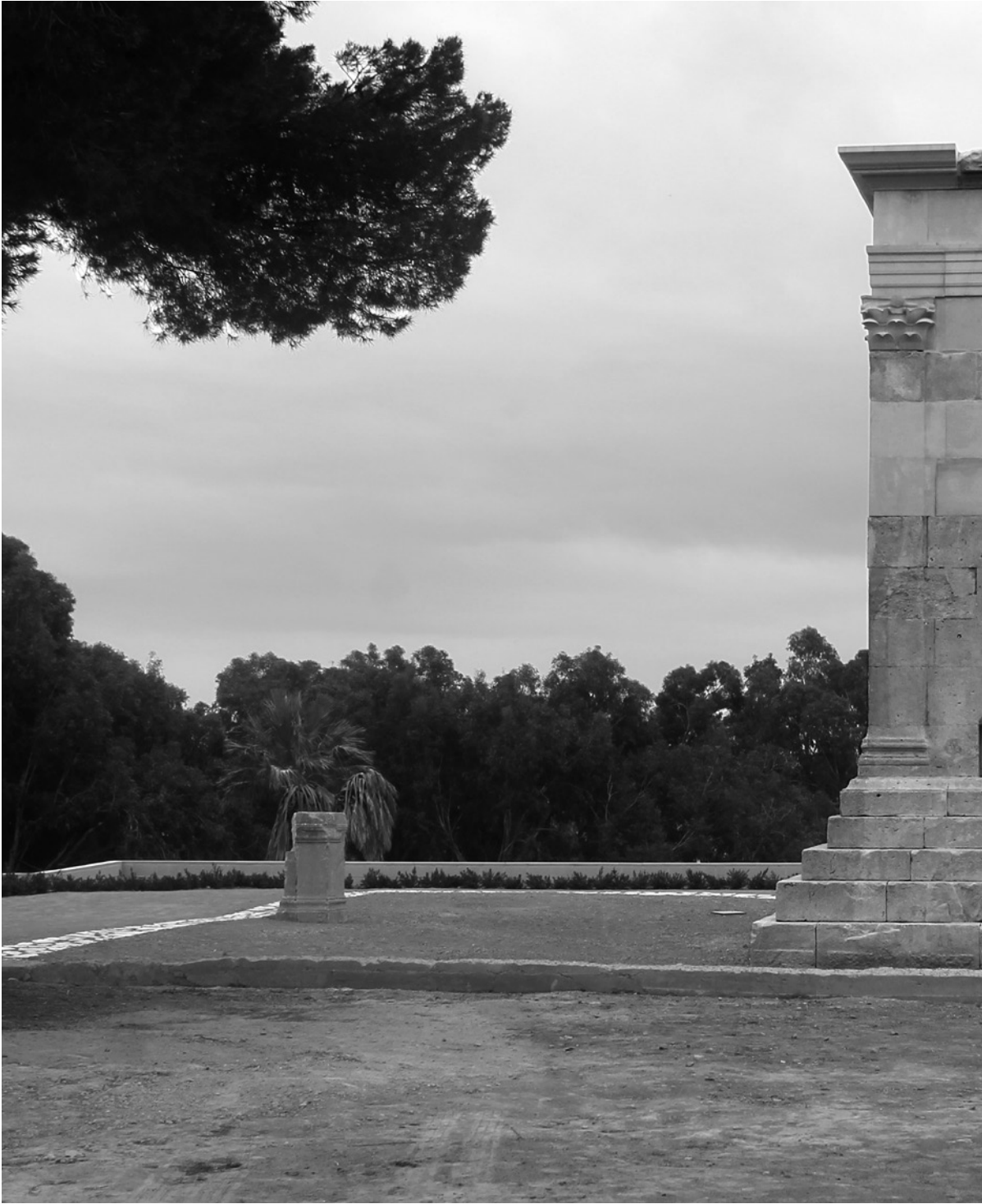
Terminación alzado norte, con la restauración del recinto funerario y colocación del ara (Foto: S.Varela Botella).
