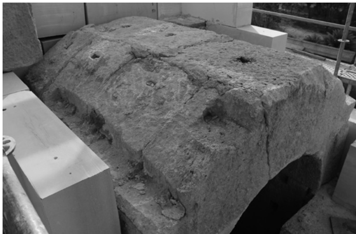
Parte superior de la bóveda y encuentro con los cerramientos (Foto: S. Varela Botella).
