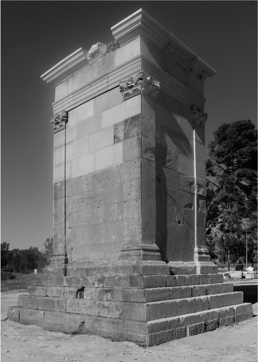
Aspecto de la terminación, esquina sureste (Foto: S. Varela Botella).
