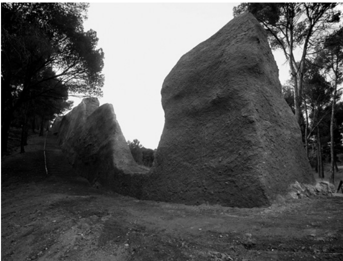
Consolidación restos ruinosos con grandes pérdidas de volumen y sin huellas de su configuración primitiva (Foto: José María Sanz).
