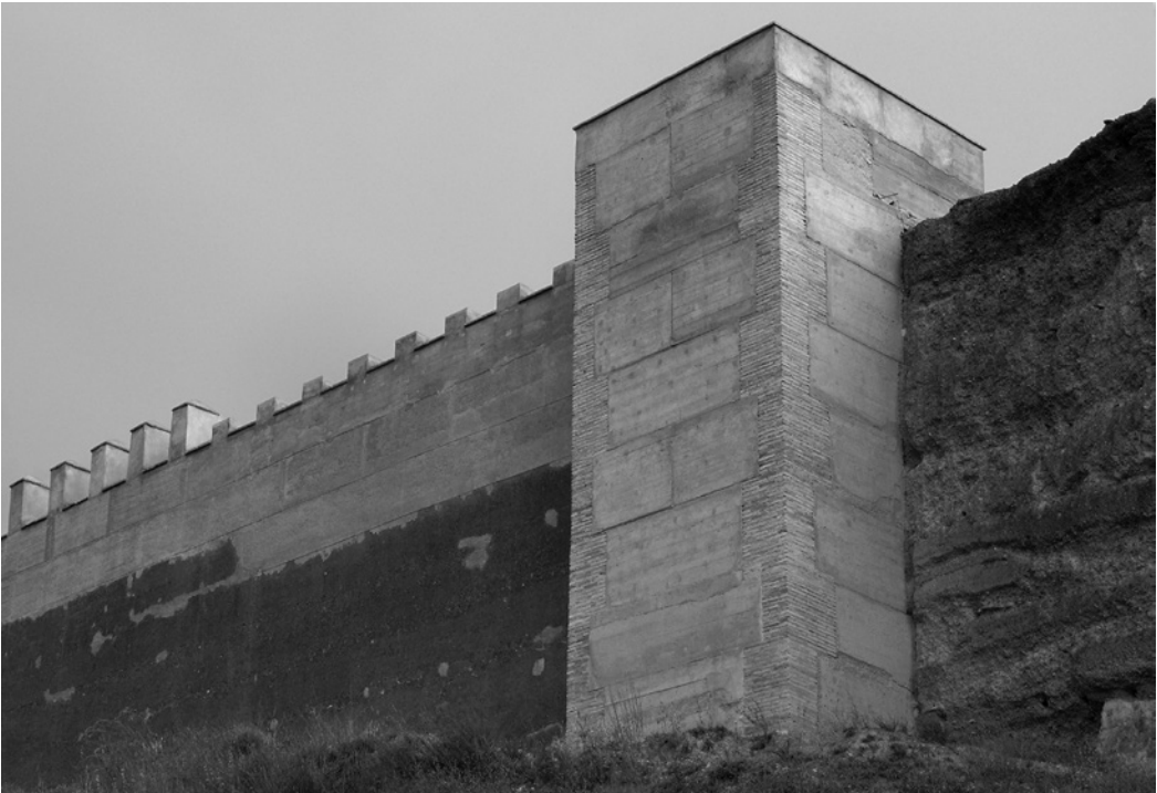
Reposición volumétrica de partes altas que conservaban almenas y restos de parapetos del adarve (Foto: José María Sanz).
