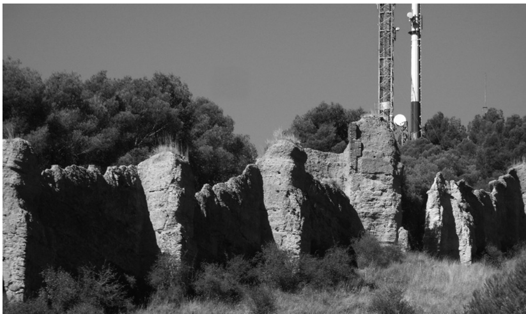
Tramo de muralla con lienzos y torreones degradados (Foto: José María Sanz).
