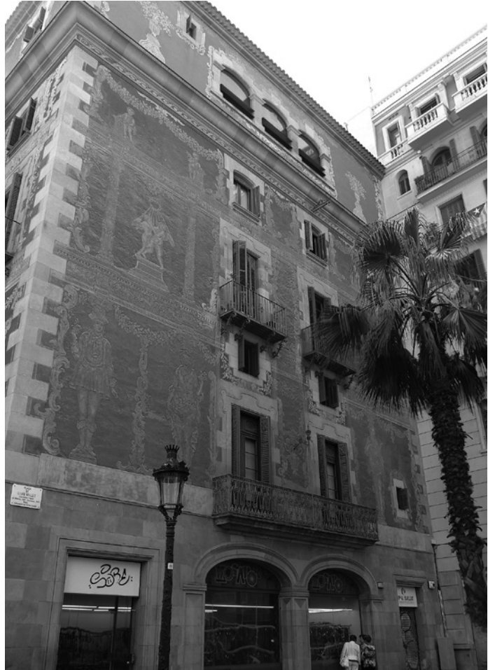
Fachada nueva de la Casa del Gremio de Velers, con los esgrafiados de F. Serra (Foto: Francesc Balañà, 2015).
