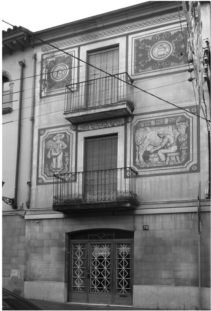
Esgrafiados de la Casa de los Payeses, en la calle Pere Puig, 78, de Martorell (Foto: R. Lacuesta, 2013).
