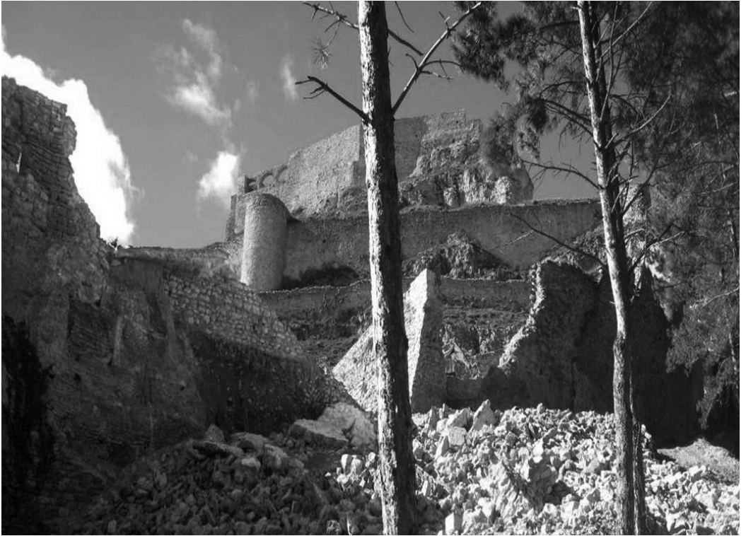
Imagen tras el segundo derrumbe, colapsando la fábrica ejecutada por Alejandro Ferrant (Foto: Elisa Moliner).
