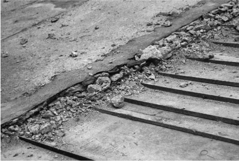
*Demolición controlada de una capa de hormigón de una intervención anterior. La capa estaba colocada en los faldones de la cubierta de una iglesia de Álava, generando una serie de patologías estructurales en las cerchas y entramados de cubierta.*
