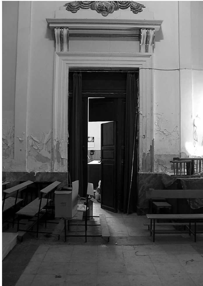
La puerta de acceso a la antigua sacristía, aspecto final (S. Varela).
