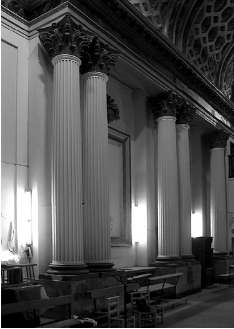
El lateral norte, aspecto preliminar y posterior a la restauración (S. Varela).
