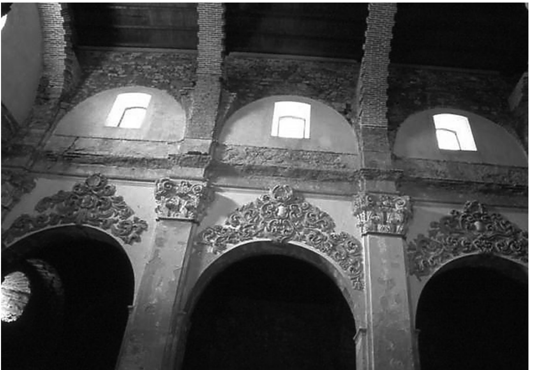
Recuperación del espacio interior de la iglesia y sus yeserías. Antes y después de la restauración (J. Naval).
