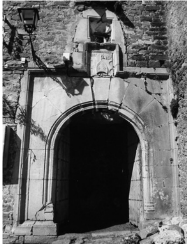
Acceso al recinto del monasterio y portada principal a la iglesia. Antes y después de la restauración (J. Naval).
