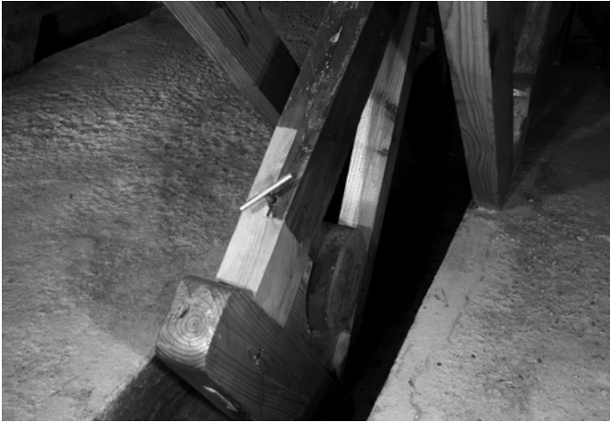
Injerto de reparación para la recuperación del alojamiento de contrapeso en uno de los balancines (M. Landa).
