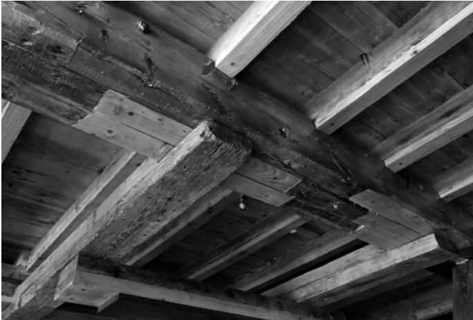
Vista del forjado de la plataforma, con las reparaciones efectuadas en las vigas principales y los refuerzos en los elementos secundarios (M. Landa).
