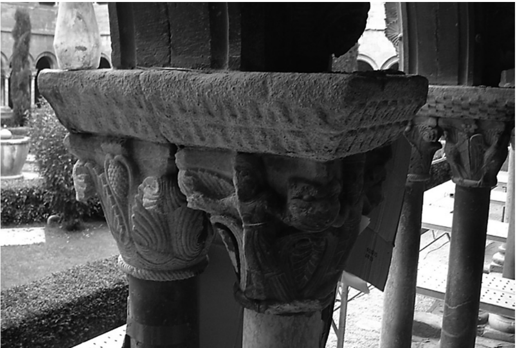
Imagen de dos capiteles, uno ya limpiado y otro a medio limpiar (A. Sierra).
