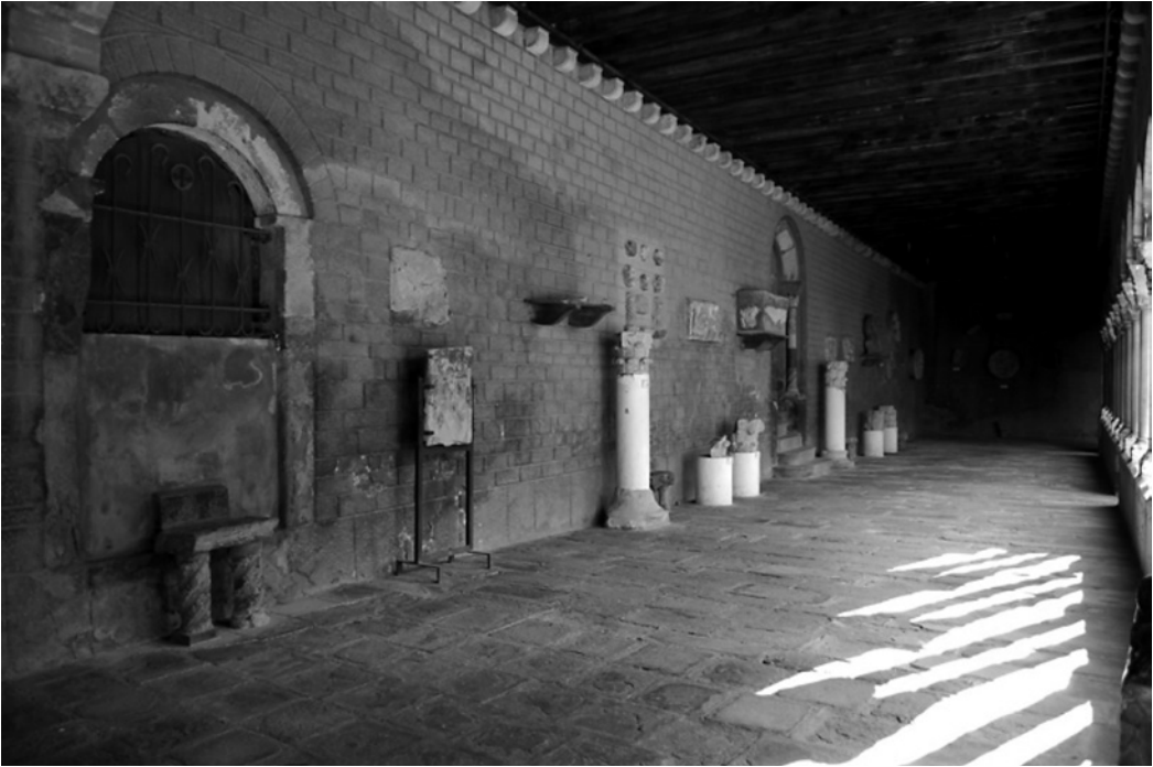
Estado del claustro antes de empezar las obras. Véase el estado de los paramentos y la presentación del lapidario (E. Colls).
