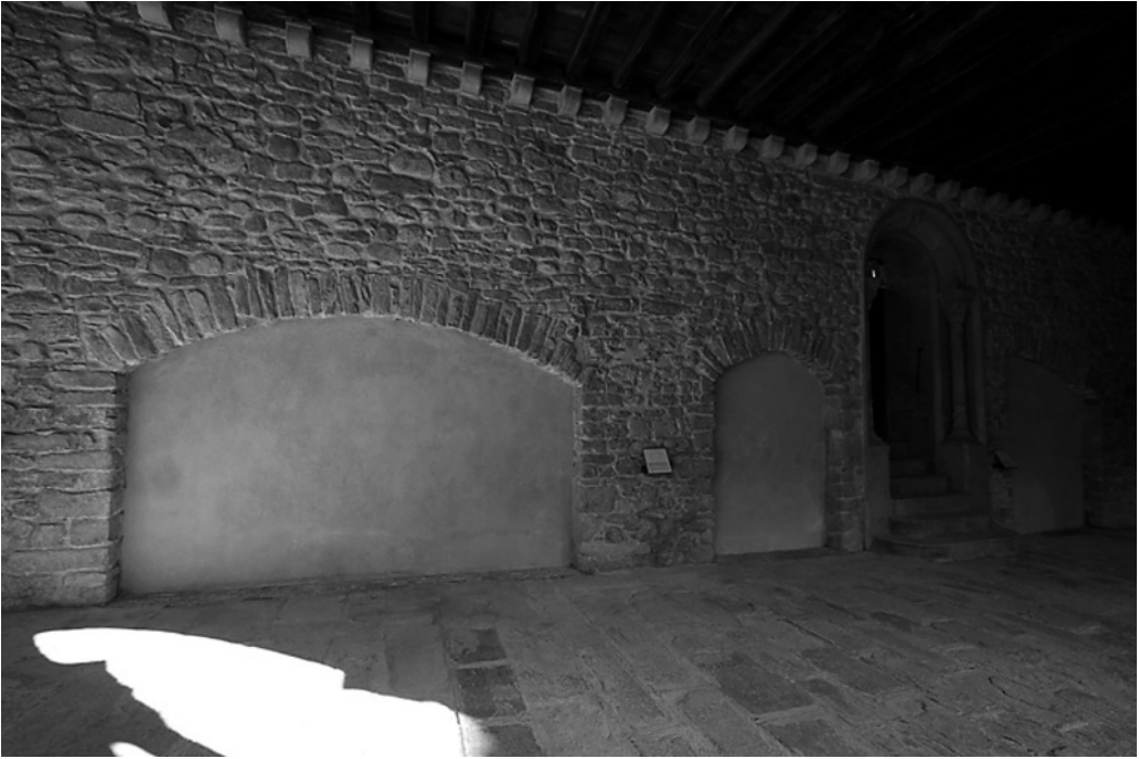
Fachada este, que muestra los restos de las antiguas aberturas de la sala capitular y la puerta restaurada, construida por Elies Rogent (A. Sierra).
