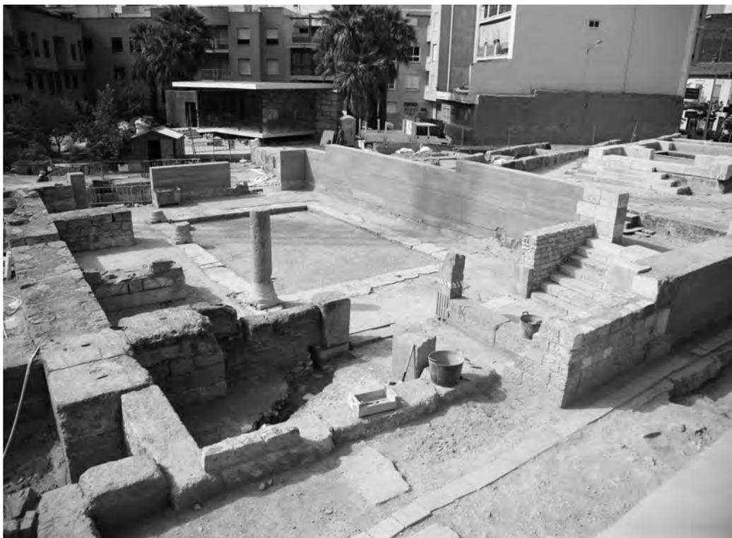
*Configuración del espacio de la basílica tras la intervención de elevación de los muros perimetrales de fábrica de tapia (J. Esteban y E. Moliner).*
