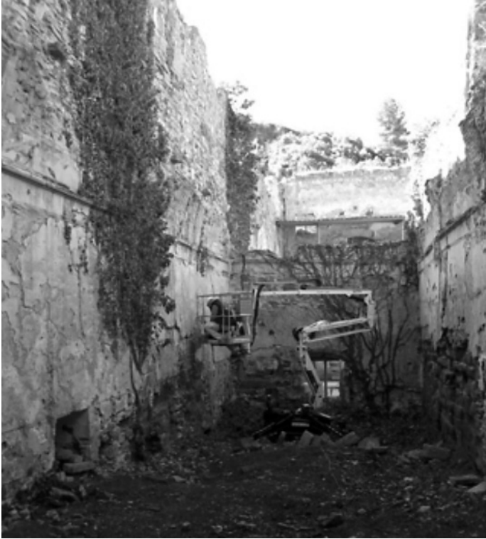
Imagen del refectorio, al principio de las obras (E. Colls) e imagen, con la cubierta y restaurado (Urcotex. E. Salas).
