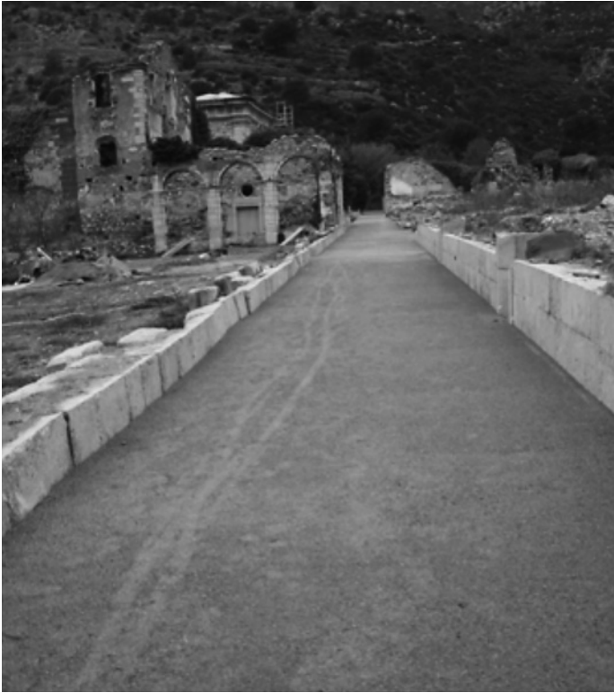
Claustro norte. Nuevo pavimento provisional sobrepuesto para protección del pavimento original (E. Colls).
