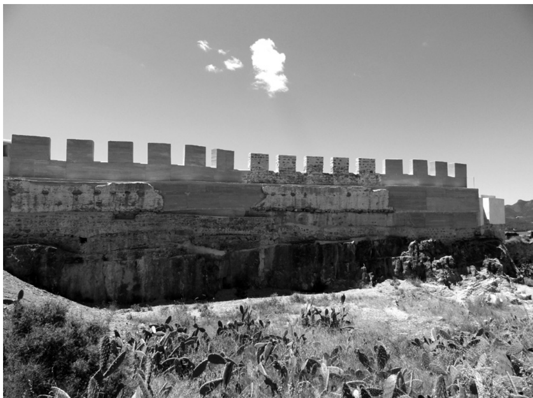
Sector 3 después de los trabajos de restauración, zona interior.
