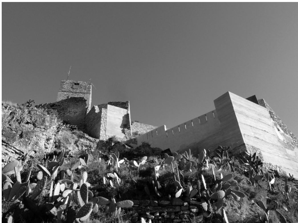
Sector 2 después de los trabajos de restauración y consolidación de la traza de la muralla medieval, zona exterior.
