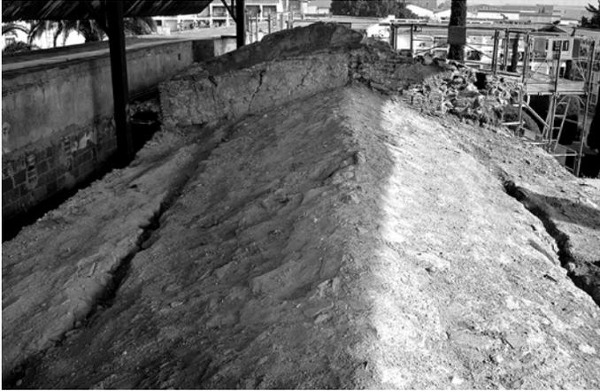
*Extradós de la bóveda, una vez excavados los rellenos de las remontas sucesivas. A los lados se pueden ver las fisuras producidas por la inclinación de los muros laterales. Foto: M. Baldomà, 03.02.2004, Archivo SPAL.*
