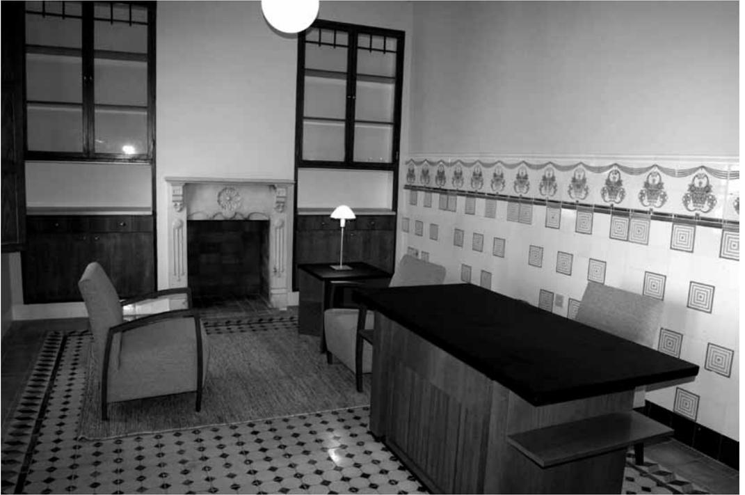
la disposición original. Se conservaban los primigenios pavimentos hidráulicos y los azulejos situados a modo de zócalos en las paredes, si bien en estado de conservación precaria y con numerosos faltantes.
