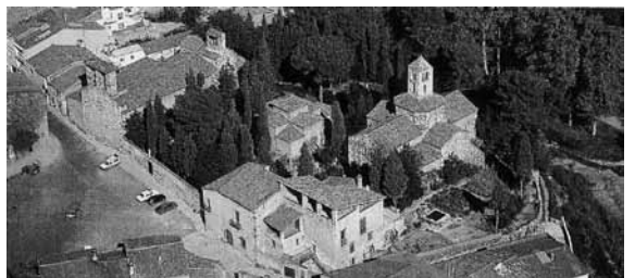
Figura 2. Conjunto iglesias de Sant Pere de Terrasa. Estado anterior del conjunto de las iglesias de Sant Pere.
