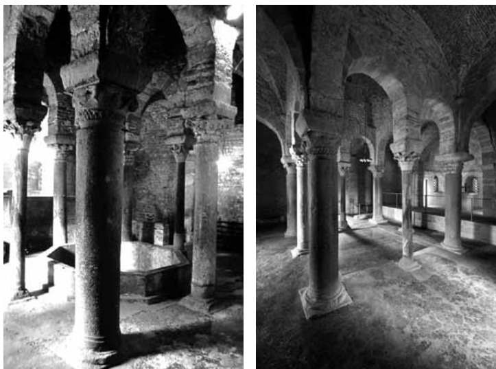
Figuras 16 y 17. Sant Miquel de Terrassa. Espacio central antes y después de la restauración
