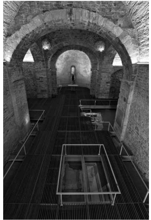
Figura 8. Santa María de Terrassa. Nave con el nuevo pavimento
