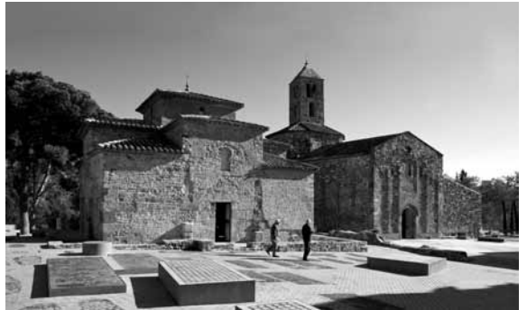
Figura 1. Conjunto iglesias de Sant Pere de Terrasa. Sant Miquel y Santa Maria restaurados.
