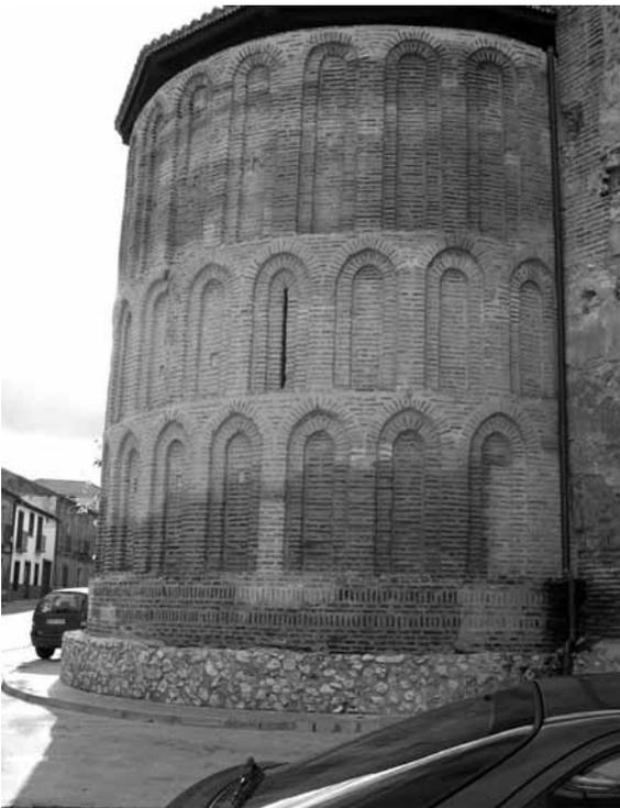
La sucesiva aparición de las degradaciones descritas depende de la manera de hacer el drenaje exterior, de la permeabilidad del terreno, de la posibilidad de evaporación del mismo en las superficies colindantes y del tipo constructivo de las fábricas.
