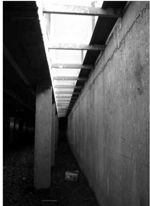
Figura 17. Centro de Educación Infantil Las Moreras en Candeleda (Ávila). Fotografía de obra (5-2-2010). Vista interior de sótano que actúa como cámara de regulación térmica y ventilación del edificio
