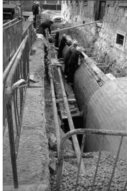
Figura 3. Palacio de Santa Cruz de Valladolid. Foto de obra. Construcción de las galerías de ventilación
