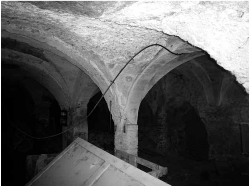
Figura 15. Planta baja de la adobería de la calle del Rec, 77, con bóvedas vaídas sobre pilares. (Foto: R. Lacuesta. SPAL, 27.12.2010)
