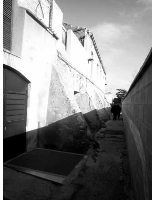
Figura 20. La acequia, a su paso por la calle Baixada de Sant Faust. (Foto: F. Balañà. SPAL, 10.12.2010)
