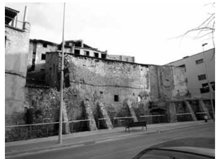
Figura 12. La nueva Ronda del Rec, trazada junto a las adoberías y dejando al aire libre la acequia, que se abre paso entre los contrafuertes del edificio. A la derecha de la fachada se puede percibir aún una plataforma elevada, el enlosado, donde se secaba la corteza vegetal para los curtidos. (Foto: F. Balañà. SPAL, 10.12.2010)
