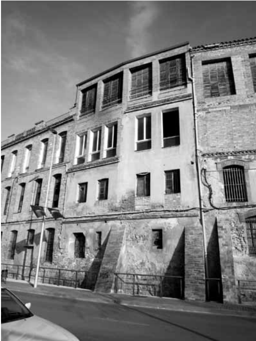
Figura 13. Detalle de una adobería con fachada a la nueva Ronda del Rec. (Foto: F. Balañà. SPAL, 10.12.2010)
