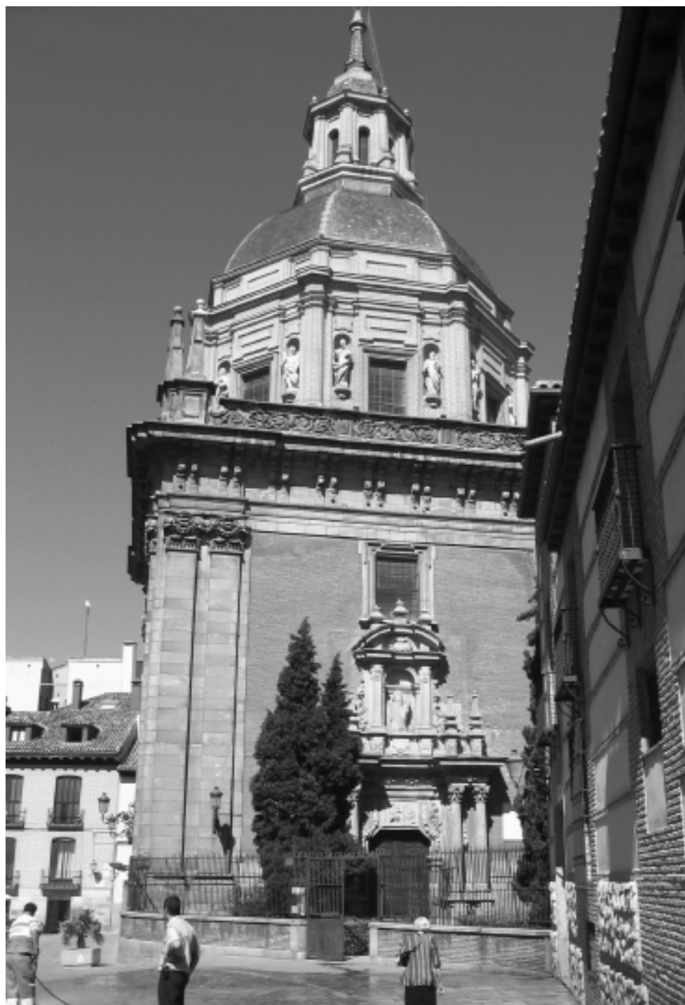
Estado actual del exterior de la capilla de San Isidro.
