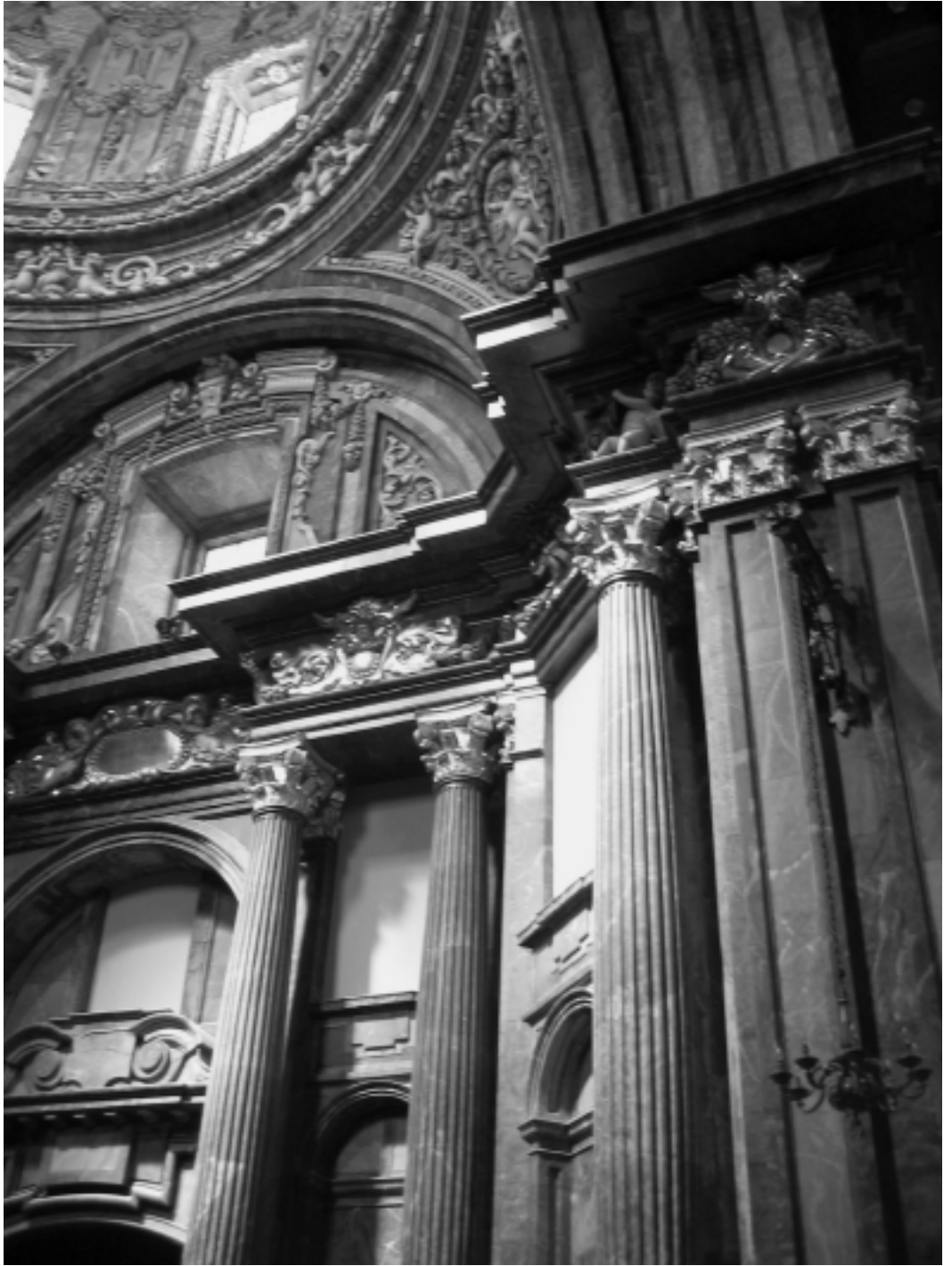
Foto del estado actual del interior tras la restauración.
