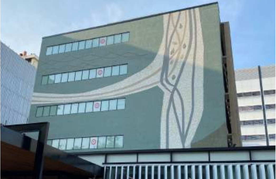
Figura 24. Imagen del mural tras la finalización del conjunto arquitectónico donde se aprecia la señalización de entrada de bomberos.
