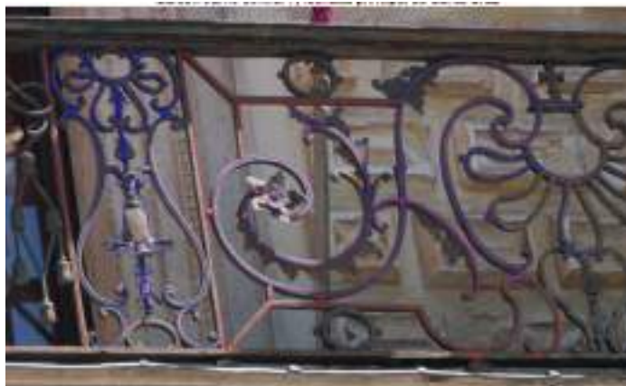
Balcón tramo central 7, fachada principal de Santa Cruz.
