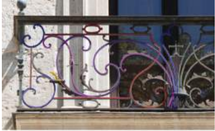
Balcón tramos 3, 5, 9 y 11, fachada principal de Santa Cruz.
