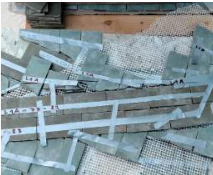
Figura 22. Preparación de los lazos antes de llevar a cabo su colocación.
