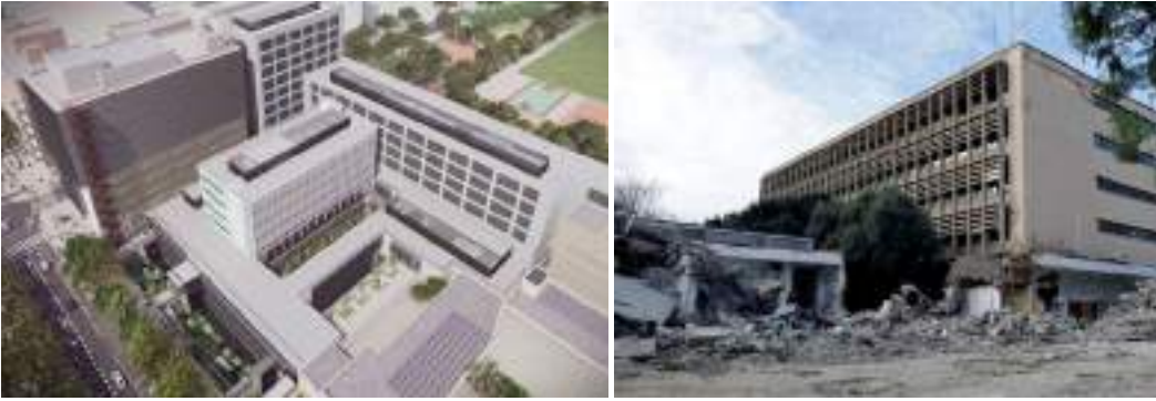
Figuras 7 y 8. Imagen del proyecto de ampliación del Hospital Clínico de Valencia y derribos de aulas laboratorio en diciembre de 2012. [Fuente: Diario Las Provincias, 29 de enero 2021]
