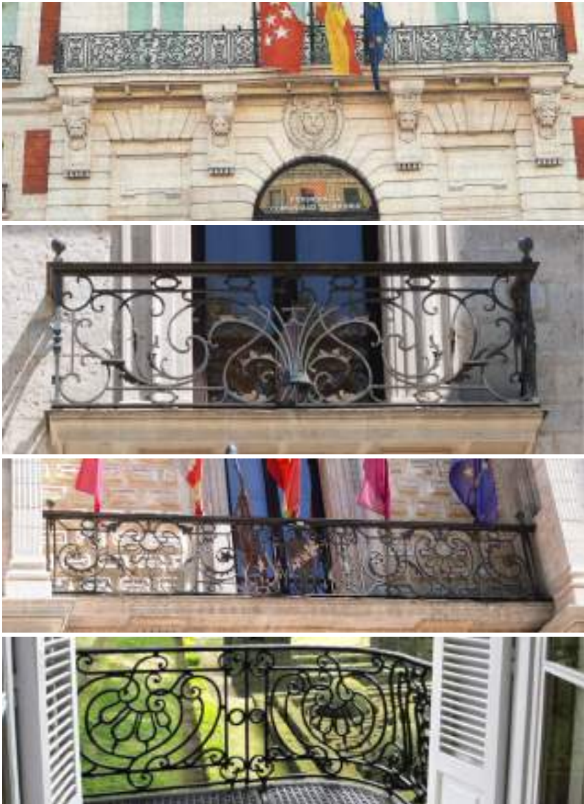
Figura 9. Ejemplos de rejerías de balcones en diferentes edificios proyectados por Ventura Rodríguez. De arriba abajo: Real Casa de Correos de Jaime Marquet y Ventura Rodríguez. 1756-1760; balcón lateral de la fachada principal del Palacio de Santa Cruz Valladolid. Ventura Rodríguez. 1768; balcón central de la fachada principal del Palacio de Santa Cruz (Valladolid). Ventura Rodríguez. 1768; Palacio de Liria. Louis Guilbert y Ventura Rodríguez 1785.
