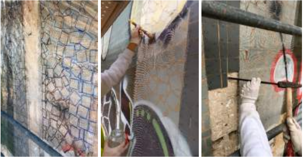
Figuras 13 a 15. Procesos de la extracción del mural: extracción de modelos, engasado por fragmentos del trencadis y extracción de las piezas de gres porcelánico.
