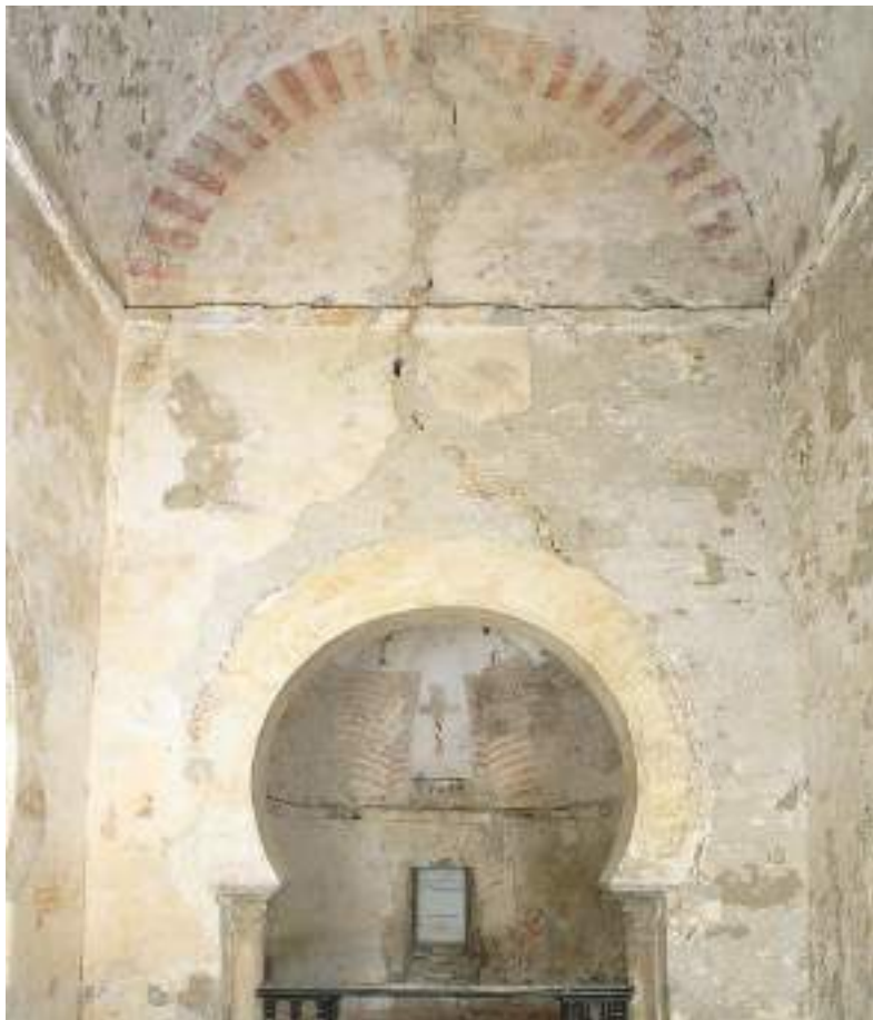
Figura 7. Hastial occidental de la nave donde se abre la capilla de San Genadio. Los enlucidos más antiguos demuestran que nunca hubo acceso desde el interior del templo a la cámara elevada (Fot.: Imagen MAS, 2004).
