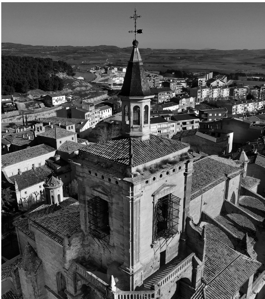
Vista suroeste del cuerpo superior de la torre antes de la restauración. (José Luis Larrión Torres).
