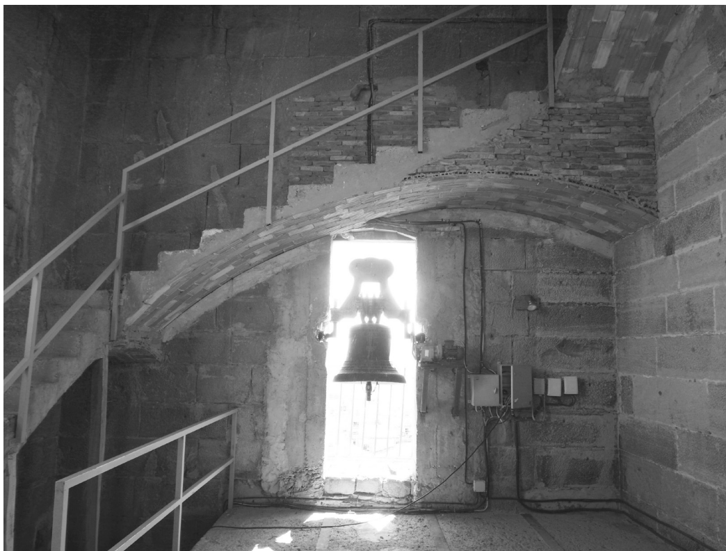
Vista del interior del campanario antes de la restauración.
