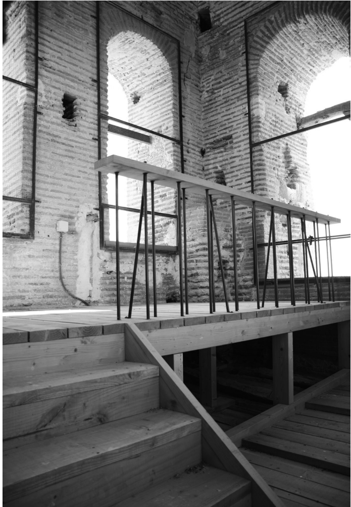
Figura 11. Interior del campanario.
