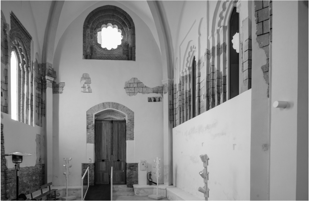
Vista interior hacia los pies, con la puerta, el óculo y los ventanales en ambos laterales recuperados. Sobre la puerta a derecha se han dejado los mechinales de las viguetas del forjado construido para convertirlo en vivienda. Los laterales de ladrillo a los lados de la puerta muestran la cota de suelo al inicio de los trabajos, por lo que se comprueba que todo el edificio ha bajado su cota prácticamente dos metros (Joaquín Zamora Muñoz)
