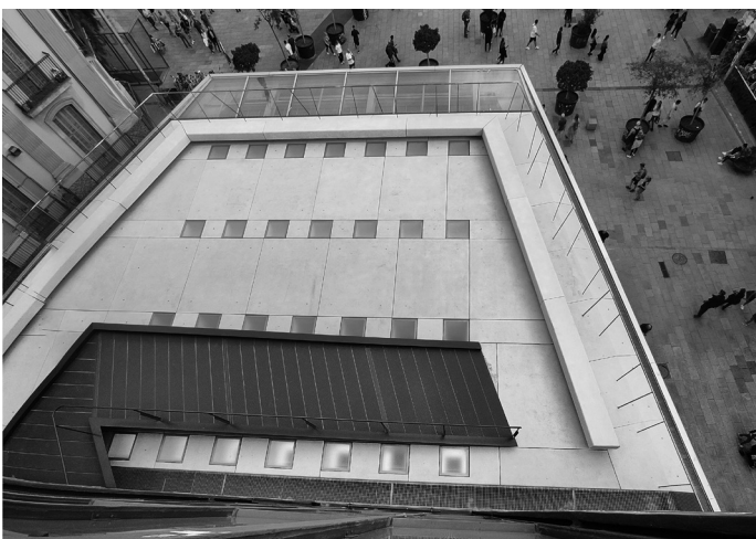
Figura 15. 2023, la terraza con los elementos introducidos para habilitarla como espacio de uso público, rampa y protección perimetral (Glòria Bassegoda Villagrasa).
