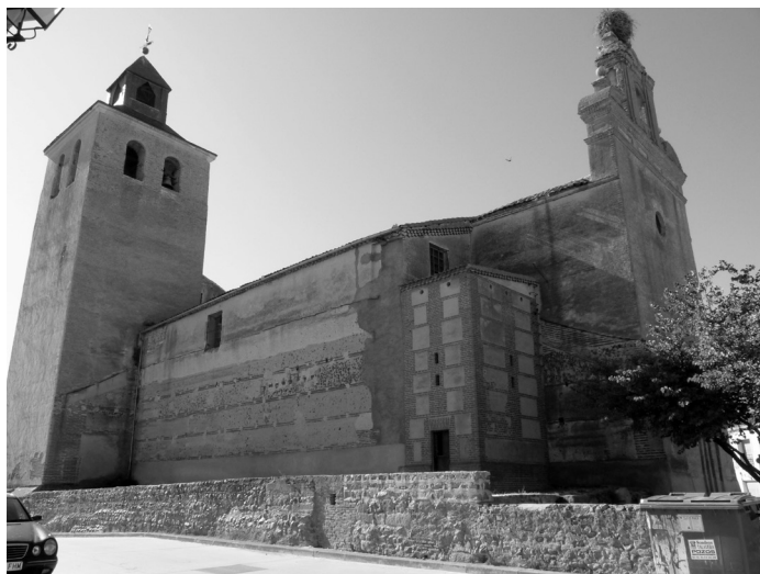
Figura 4. Vista de la iglesia desde el noroeste, antes de la restauración.
