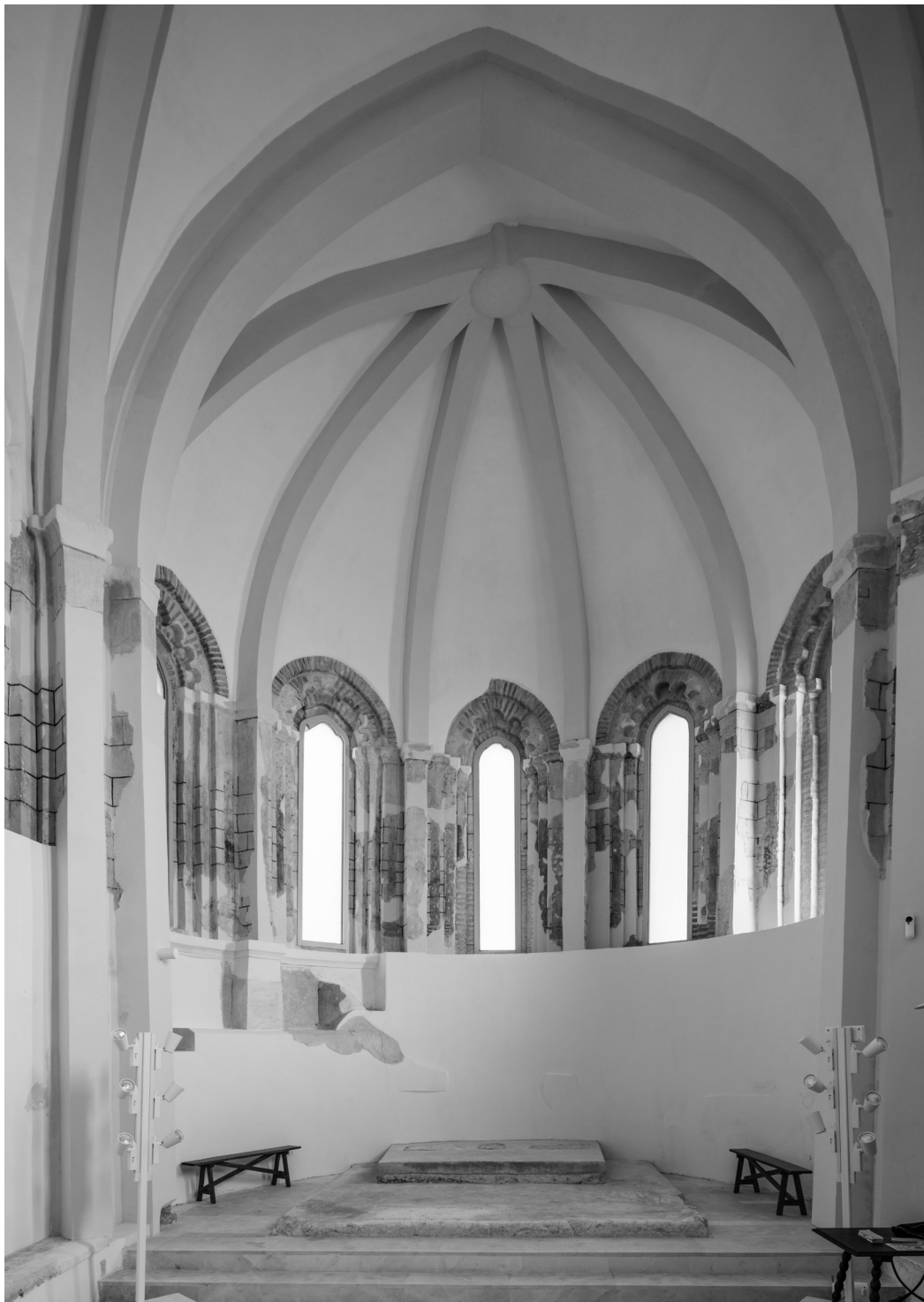
Vista interior del ábside, una vez finalizados los trabajos (Joaquín Zamora Muñoz)
