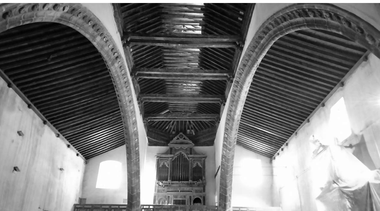
Figura 10. Vista final del aula, con sus armaduras recuperadas.
