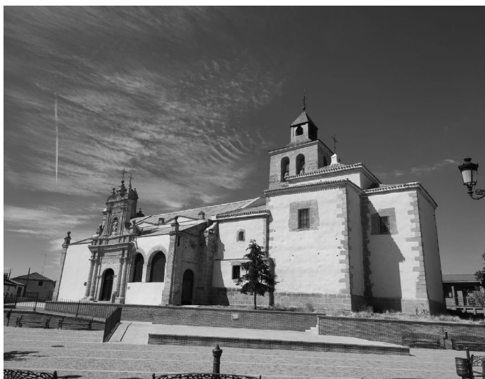
Figura 16. Vista general de la iglesia, desde la plaza, una vez concluida la restauración.
