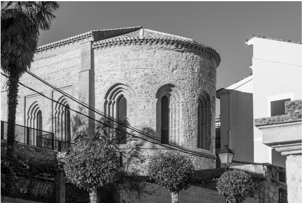
Vista del ábside de San Simón desde la calle Mayor. Arriba, antes de la restauración, completamente oculto por la vegetación y por el edificio adosado. Abajo, una vez finalizadas las obras se puede contemplar tanto el ábside como la nave prácticamente íntegros.
