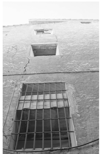
Fachada al carreró.
