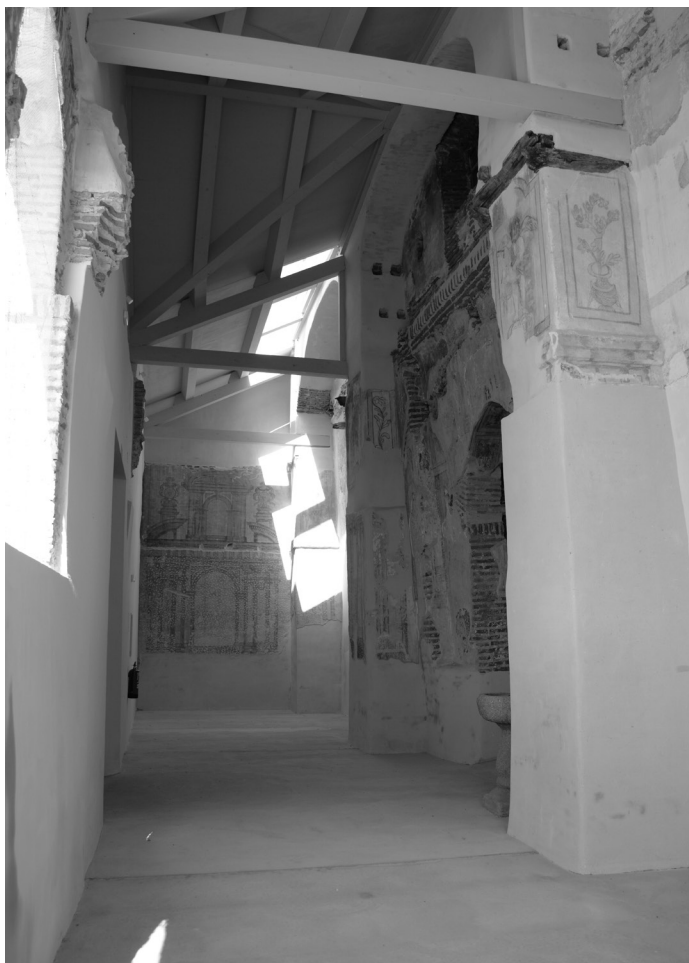
Figura 15. Atrio de la iglesia, una vez recuperadas sus dimensiones y proporciones, configurado como capilla exterior. A la izquierda, las dos arcadas liberadas de la fábrica que las cegaba. Al fondo, la representación pictórica de un retablo, recuperada en su totalidad. A la derecha, estructura de contrafuertes estribados por arcos, con tres niveles de decoración mural.
