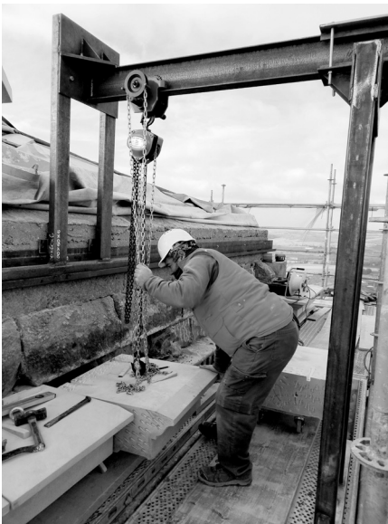
Medios auxiliares empleados para la colocación de las nuevas piezas de la hilada superior de la cornisa de coronación.
