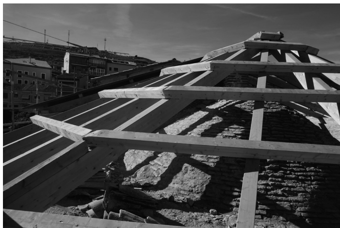
Trabajos de ejecución de la armadura de madera sobre el ábside (al fondo también se aprecia la de la nave), ajustándose a las cotas de durmientes originales y sin afectar al trasdós de la bóveda.
