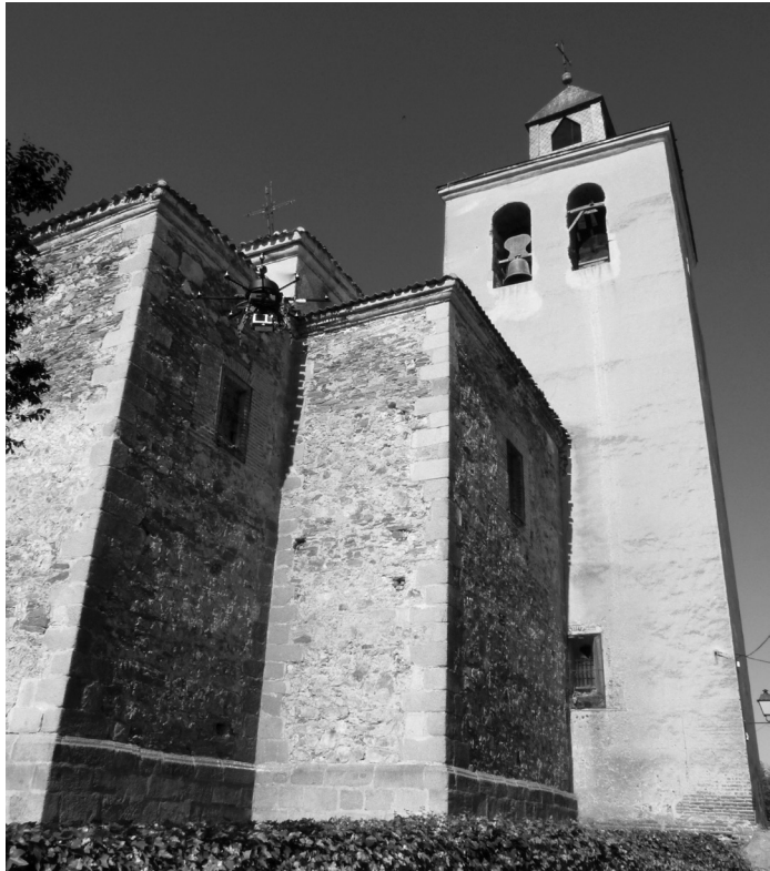
Figura 7. En primer plano, y antes de la restauración, la cabecera barroca con la mampostería vista, después de que fuera despojada de su revoco en 1971. Al fondo, la torre vigía, enfoscada en toda su altura.
