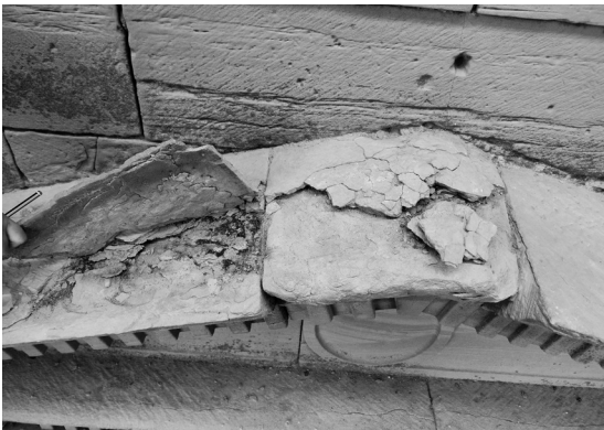
Estado previo a la restauración. Cornisa del nivel de la terraza -arriba izquierda-; jambas -arriba derecha- y frontones -abajo- de los vanos del cuerpo de campanas.
