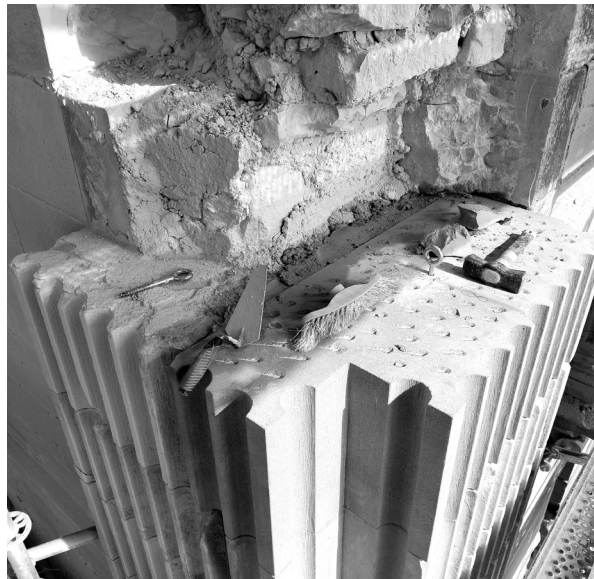
Sustitución de sillares en las esquinas apilastradas.
