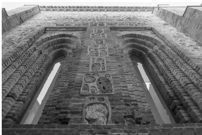
Vista exterior de la fachada de la nave en el lado del evangelio, una vez finalizados los trabajos (Joaquín Zamora Muñoz).
