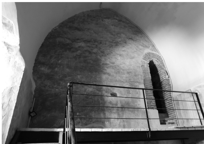
Figura 12. Plataforma incorporada en la cámara inferior de la torre vigía.
