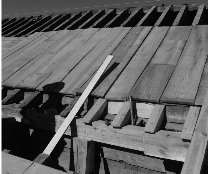
Figura 9. Restauración de la armadura de la nave central.
