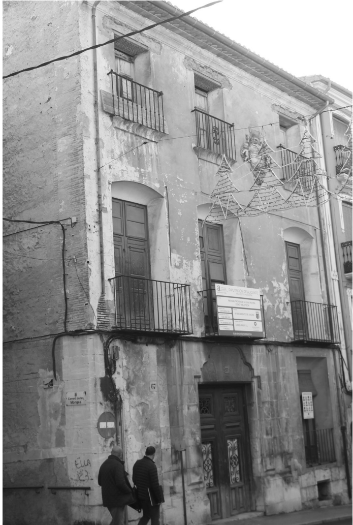
Fachada principal estado inicial.
