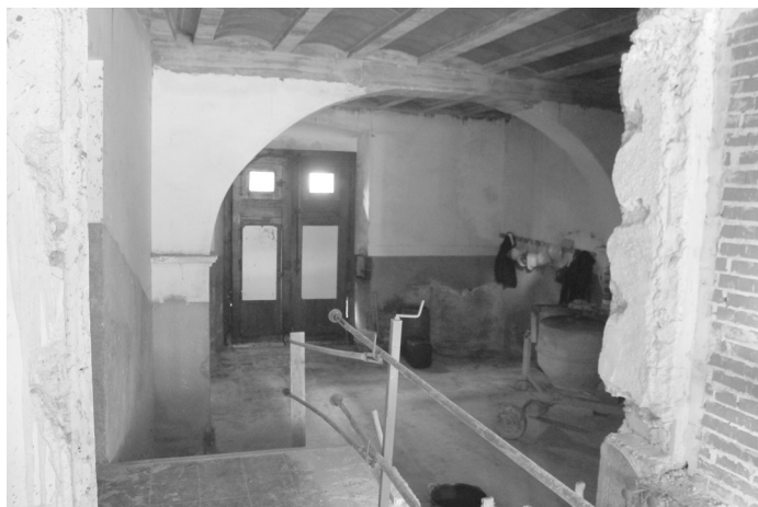
El vestíbulo desde el interior.
