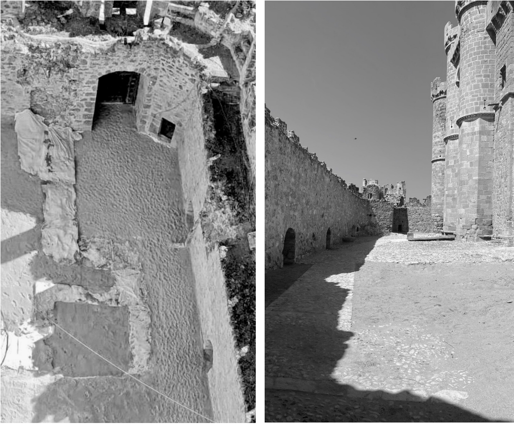
Figura 15. Estado final de la liza en septiembre de 2023, con los restos enterrados en arena, dejando a la vista los pavimentos de canto rodado, de los que se desconoce la fecha de su realización. Los restos fueron recubiertos con una lámina de geotextil y arena. Poco tiempo después el viento y las lluvias van colocando la arena en su lugar, dejando al descubierto el geotextil. Aún no había empezado el invierno (Javier Ramos Guallart).
