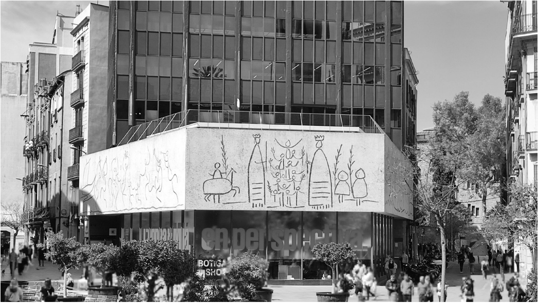
Figura 18. El friso con esgrafiados diseñados por Picasso, que dispone de declaración como BCIN. Se puede ver la inadecuada y potente presencia del banco y la barandilla perimetrales colocados con motivo del cambio de uso (Glòria Bassegoda Villagrasa).
