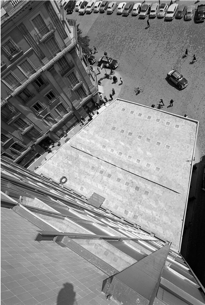
Figura 14. 1962, la terraza del cuerpo avanzado en la plaza Nova. (www.renovaciourbana.com/historia-edifici, Oriol Maspons Casades, consultada 03-2023).
