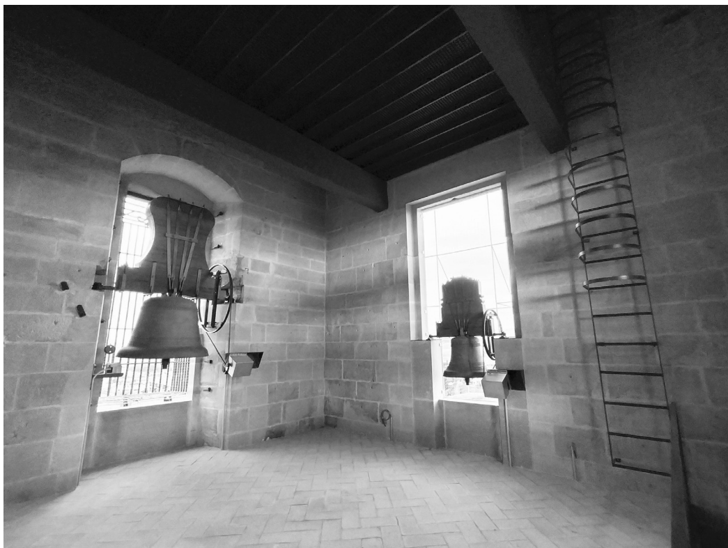
Interior del campanario tras la restauración.
