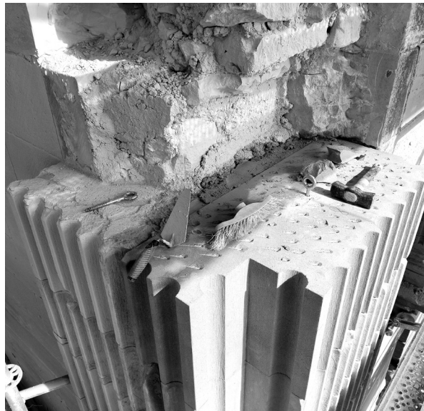
Sustitución de sillares en las esquinas apilastradas.
