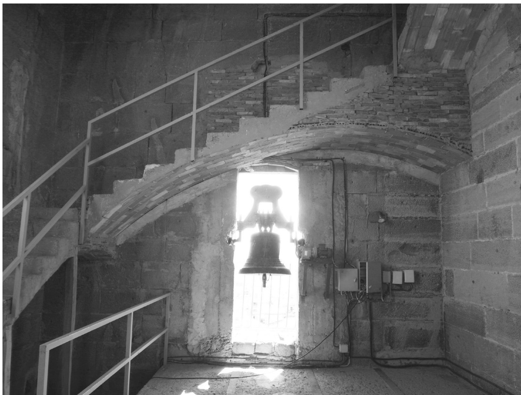
Vista del interior del campanario antes de la restauración.
