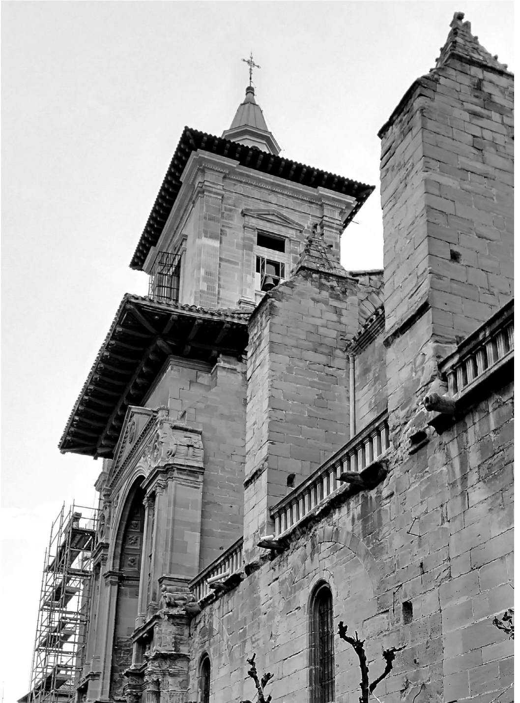
Vista desde la Rúa de Santa María en la que se distinguen la portada principal de la iglesia y el cuerpo superior de la torre, poco antes de la finalización de las obras.
