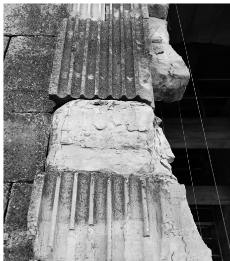
Estado previo a la restauración. Cornisa del nivel de la terraza -arriba izquierda-; jambas -arriba derecha- y frontones -abajo- de los vanos del cuerpo de campanas.
