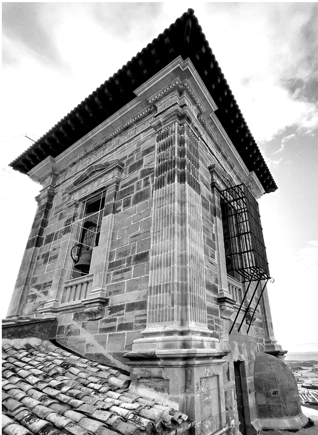
Coronación del cuerpo superior de la torre tras la restauración.
