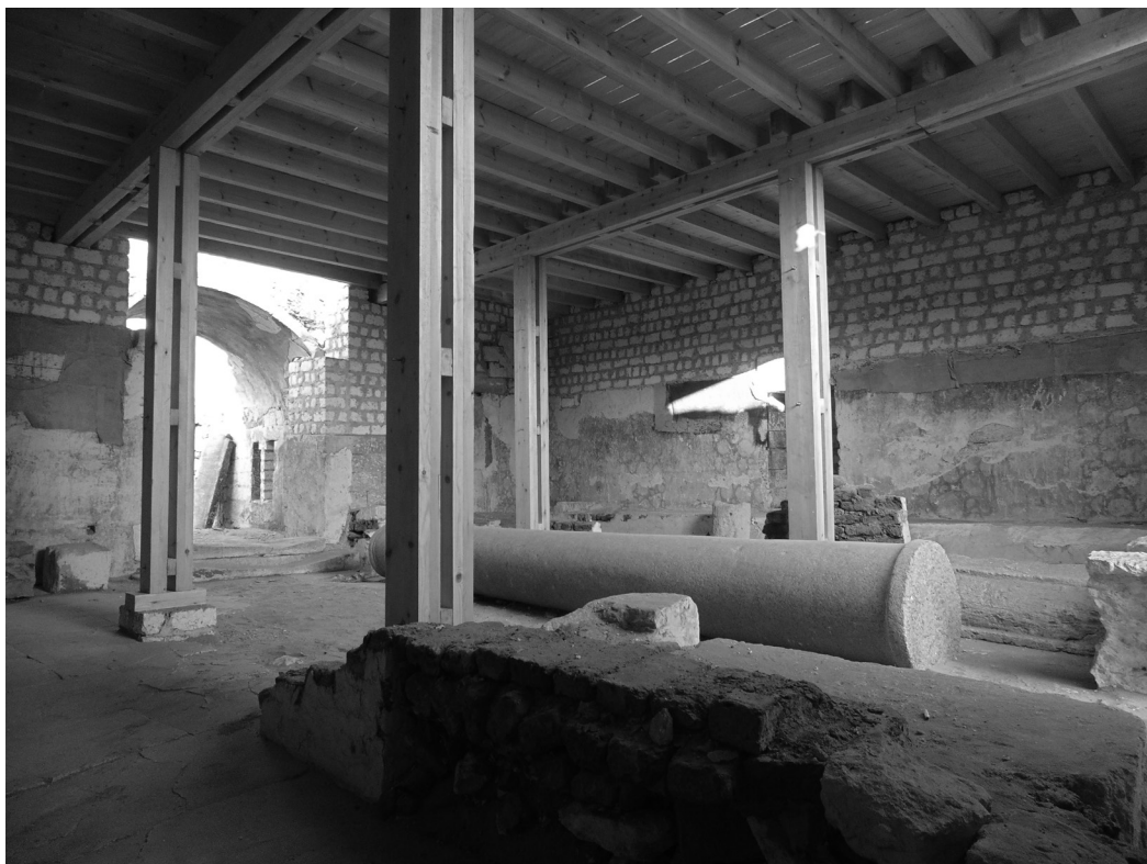
La estructura desde el interior. En primer término, murete de fase de expolio.
