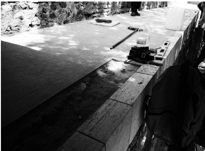
Reconstrucción del suelo del adarve con un hormigón de cal y sillares de travertino utilizados como bordillo.
