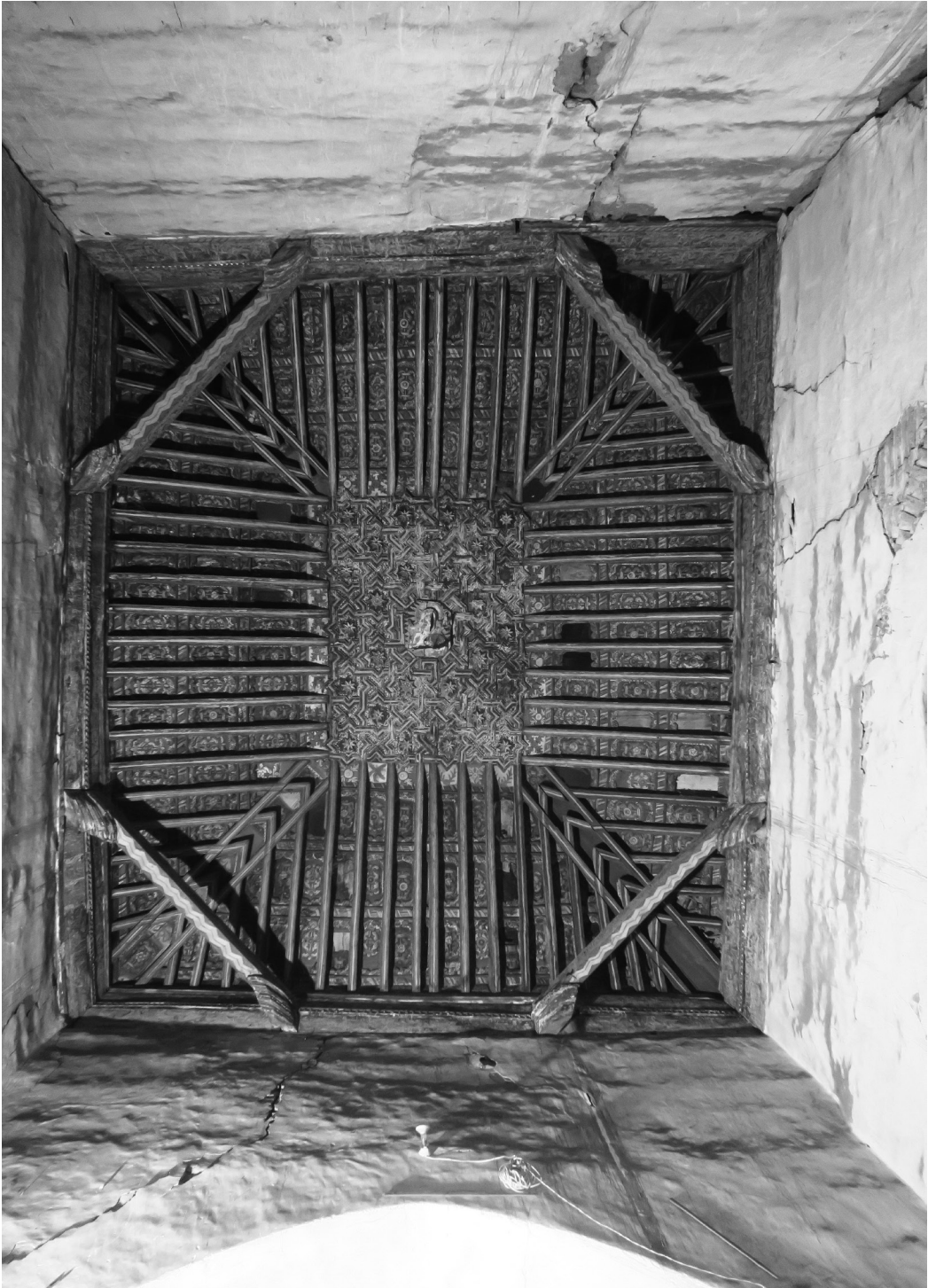
Armadura de cubierta de la estancia cuando se convirtió en la capilla de San Juan.
