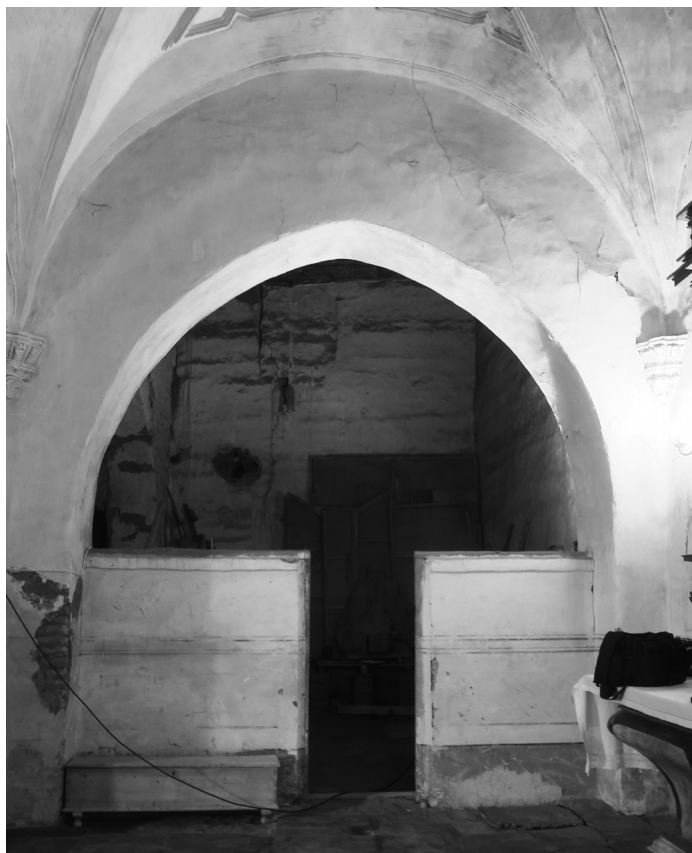
Estancia situada al oeste de la nave norte.
