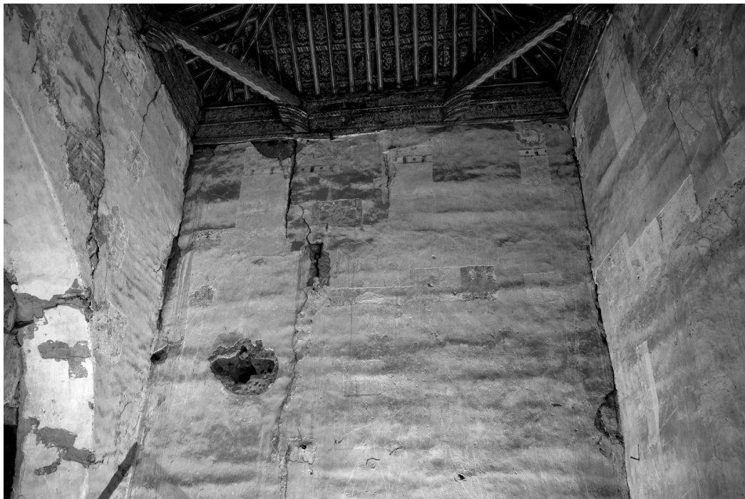
Paramento oeste de la estancia, iluminado con luz rasante.
