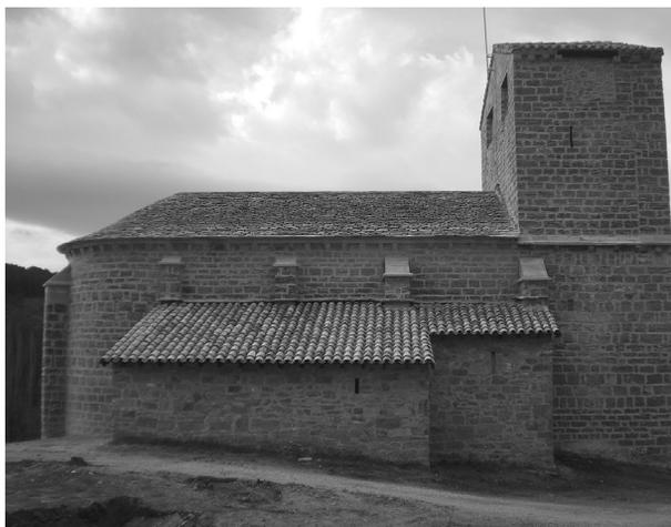
En la restauración de la iglesia de Vesolla se mantuvo la bóveda de fábrica como soporte del material de cobertura, pero se añadió una capa impermeable y se fijaron las lajas con mortero de agarre (fig.13). Al incluir una capa impermeable se alarga la vida útil del sistema sin que requiera un mantenimiento periódico, pero la introducción de este nuevo elemento tiene varias implicaciones:
