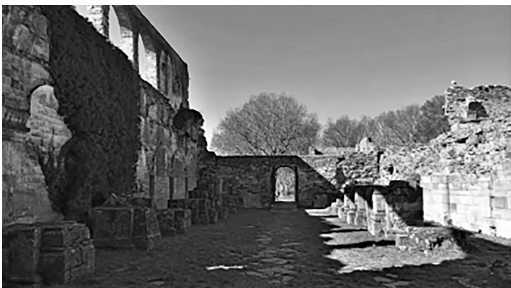
Nave de la iglesia. Antes y después de su intervención en 1997 y actualmente, 2022, con vegetación controlada.
