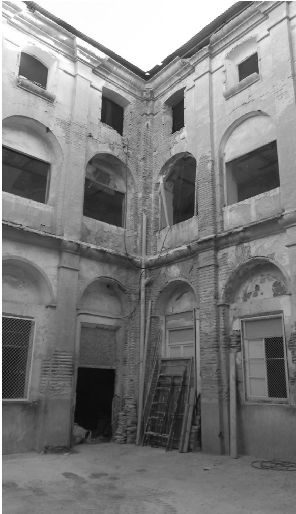
Antiguo convento de San francisco. Estado del patio antes de la intervención.
