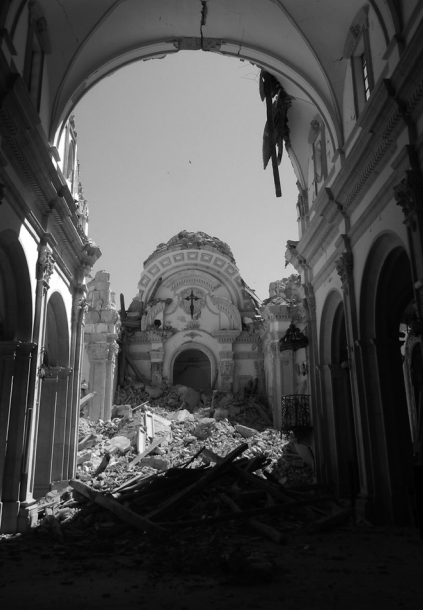
Vista de la nave central de la iglesia de Santiago Apóstol en Lorca, antes y después de los terremotos de mayo de 2011.
