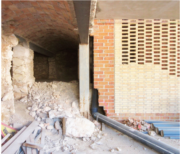
Figura 8. Imagen del proceso de obra del espacio de instalaciones (Arquitectura Genís Planelles).
