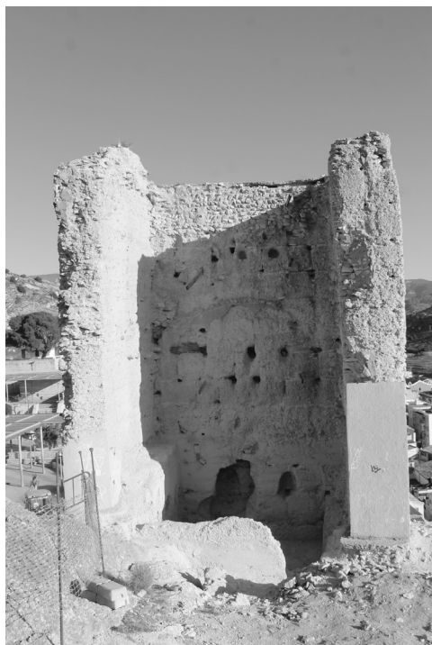
Torre Grossa, aspecto antes de la restauración (D. Tarcoso).
