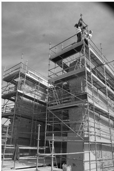
Torre Grossa durante los trabajos (D. Tarcoso).
