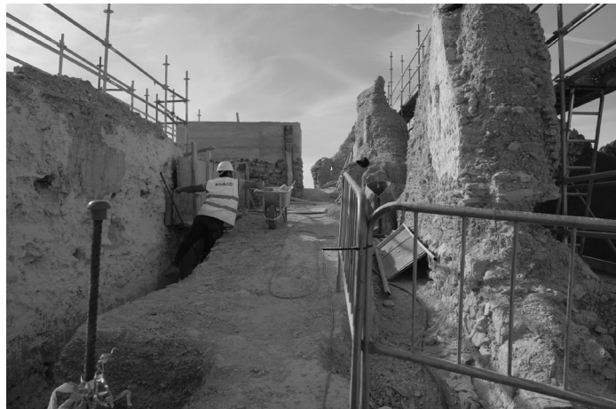
Los trabajos en el interior.
