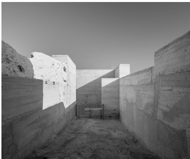
Interior del extremo norte de la alcazaba (D. Tarcoso).
