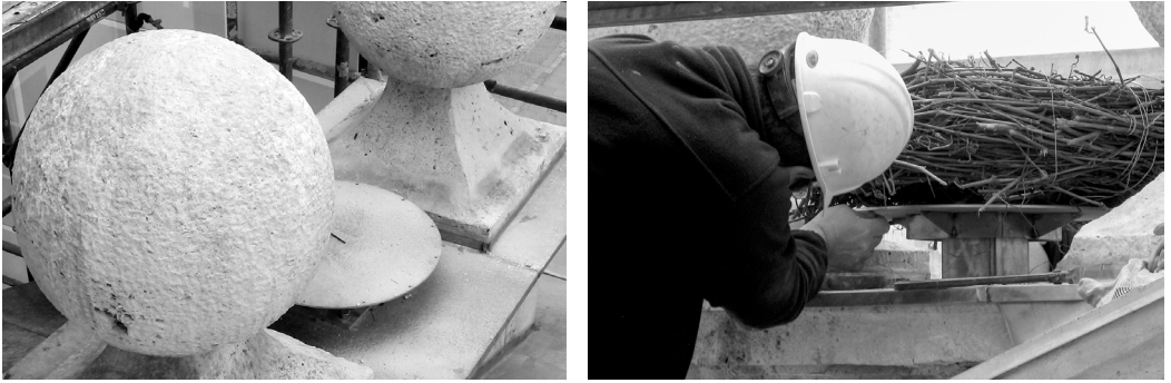
Figura 13. Instalación de los nuevos nidos de sarmientos sobre plataformas circulares de acero inoxidable, centradas entre las esferas de los pedestales de la espadaña.
