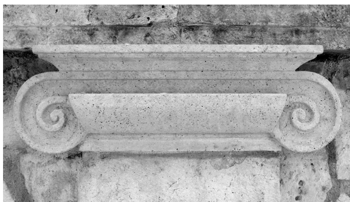
Figura 11b. Nuevo capitel de piedra de Colmenar en sustitución del dañado.
