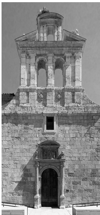
Figura 17. Cara norte de la fachada restaurada. Julio de 2022.
