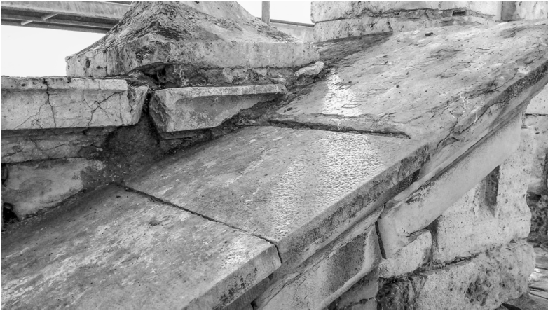
Figura 5. Cara norte de la cornisa del frontón oriental, repuesta con piedra de Almorquí-Novelda probablemente en la segunda década del siglo XX. La pieza derecha es un fragmento de lápida de tumba. Se aprecia el desajuste que la intervención produjo entre las piezas de piedra originales.
