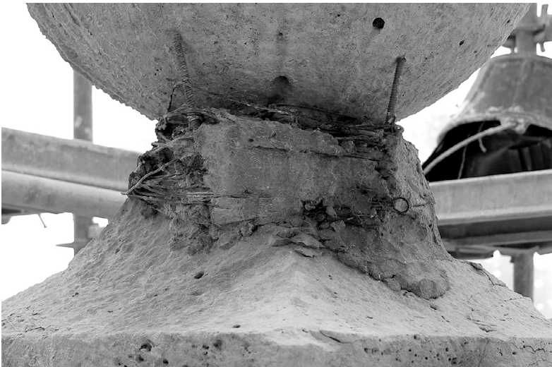
Figura 6a. Apuntalamiento de la esfera oriental del frontón, hecho con varillas roscadas, alambre y un cinturón de tela.
