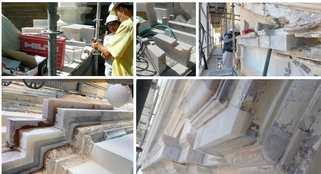
Reparación de cornisas con piedra de alabastro.
