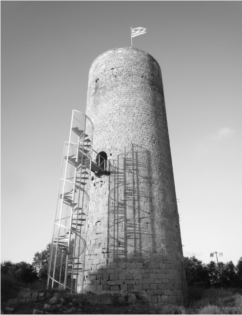
Figura 8. La torre del castillo de la Manresana, en Els Prats de Rei, años después de la intervención de los arquitectos Antoni González y Víctor Argentí, con la escalera metálica exterior (Raquel Lacuesta, 2 de enero de 2011).
