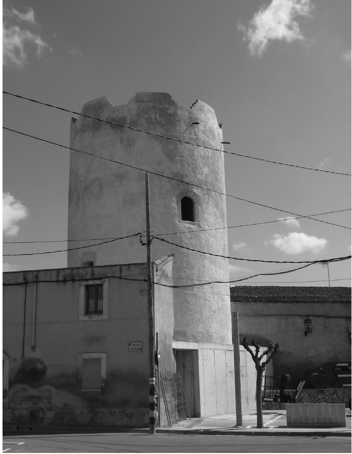
Figura 2. Olèrdola. Torre del núcleo urbano de Moja, restaurada, con la casa anexa delante y otras edificaciones alrededor (SPAL, Diputación de Barcelona, 2011).
