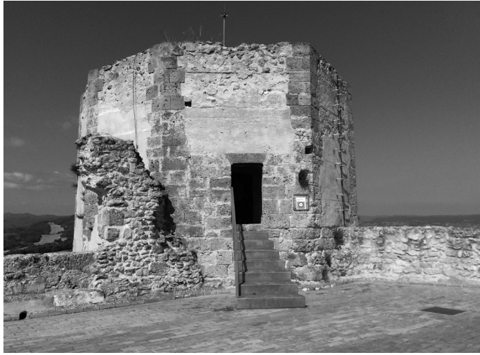
Figura 12. La Pobla de Claramunt. Nueva escalera de acceso a la torre del Homenaje del castillo de Claramunt, que ya no presenta el coronamiento de hormigón colocado en la década de 1980 (Marylène Pitscheider, 20 de agosto de 2021).
