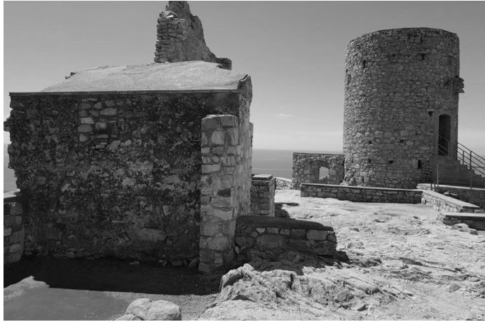
Figura 4. Castillo y Torre Mayor de Burriac (Cabrera de Mar), con el acceso adaptado para la visita pública y los muros protegidos con hormigón en 1994 (Diputación de Barcelona, 2021).
