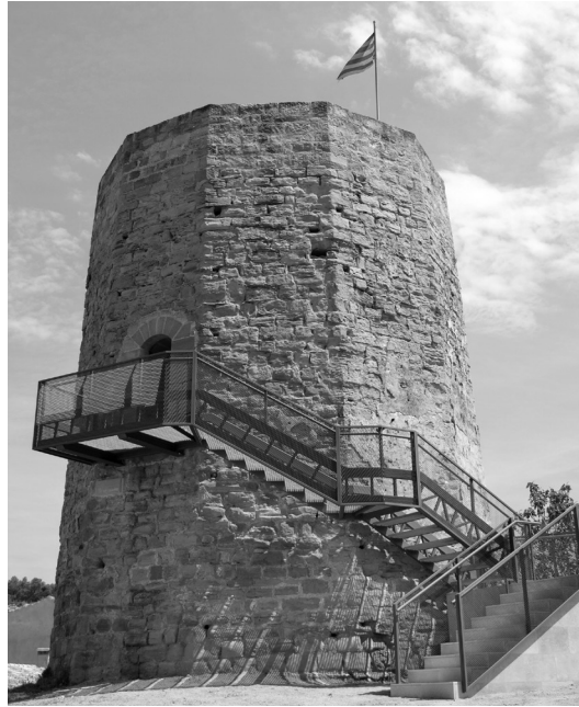
Figura 9. Ódena. Torre del antiguo castillo. Escalera añadida unos años después de la restauración del monumento para acceder a la poterna superior, en cumplimiento de la normativa vigente (SPAL, Diputación de Barcelona, Montserrat Baldomà, 30 de junio de 2011).
