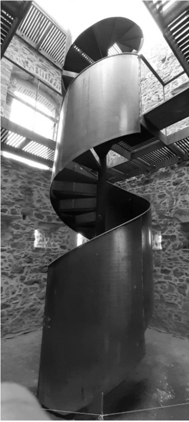
Figura 11. Avinyó. Torre dels Soldats. Nueva escalera de acceso a las plantas superiores y al atillo de listones metálicos que facilita el recorrido perimetral por los antepechos de la torre (SPAL, Diputación de Barcelona, 2018).
