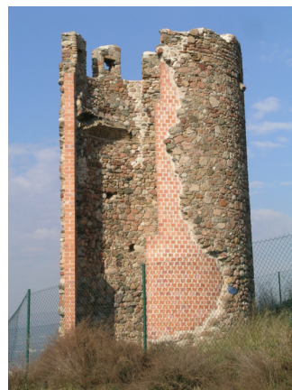
Figura 7. Torre de Pinós, Granollers, después de la actuación de urgencia dirigida por José Luis Sanz Botey, de l'SPAL. Formación de contrafuertes escalonados de obra vista (Imma Vilamala, SPAL, 22 de diciembre de 2006).
