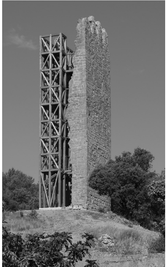
Figura 14. Torre de vigía del castillo de Merola (Puig-reig). Vista de la estructura de nueva planta con los restos de la torre gótica (SPAL, Diputación de Barcelona, 2020).
