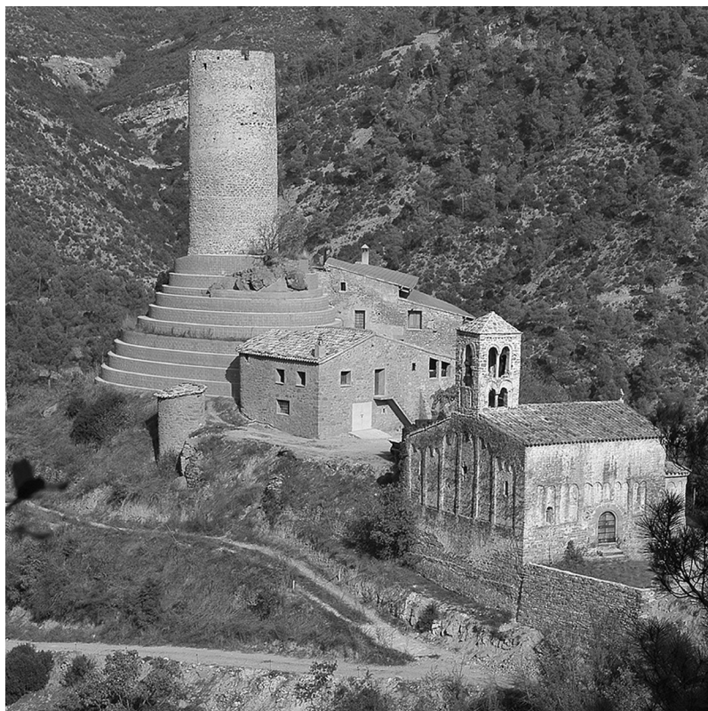
Figura 5. La torre del castillo de Coaner, una vez restaurada y reforzada la base de soporte del cerro en que se asienta (SPAL, Diputación de Barcelona, Montserrat Baldomà, 2004).
