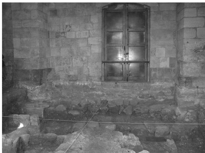
*Vestigio de la cimentación del pilar que soportaba la arquería doble de Santa María la Nueva de Zamora. Las hiladas de los contrafuertes no coinciden con las de la fábrica románica.*
