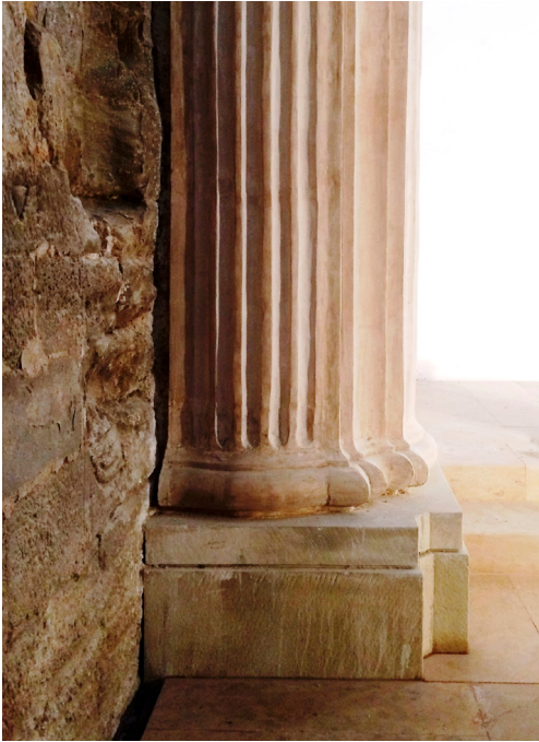
Basa de una de las pilastras de la Capilla de la Inmaculada tras la intervención. 2020.
