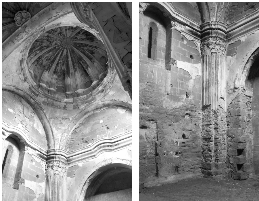
Capilla de la Inmaculada. Estado inicial antes de la intervención de 2020.
