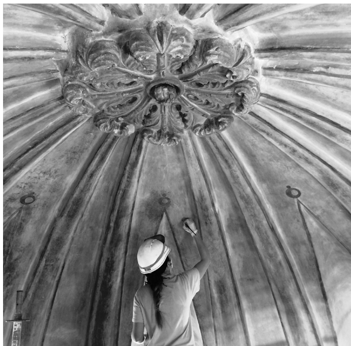
Recuperación del enlucido de mortero de cal original, que estaba pigmentado en tonos ocres y presentaba un perfilado oscuro del borde de los nervios y lunetos de la cúpula.
