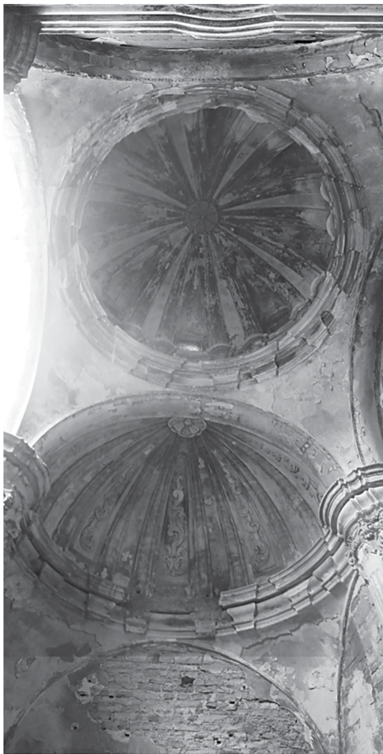
Estado inicial y estado final tras la intervención realizada en la cúpula de la Capilla de la Inmaculada.
