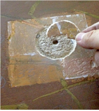
Figura 7. En detalle, extracción de muestra del revestimiento original de las paredes de la Casa Batlló.
