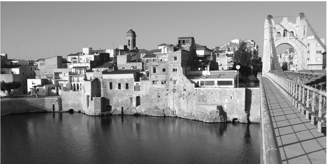
Vista de parte de la fachada fluvial de Amposta. Año 2019.
