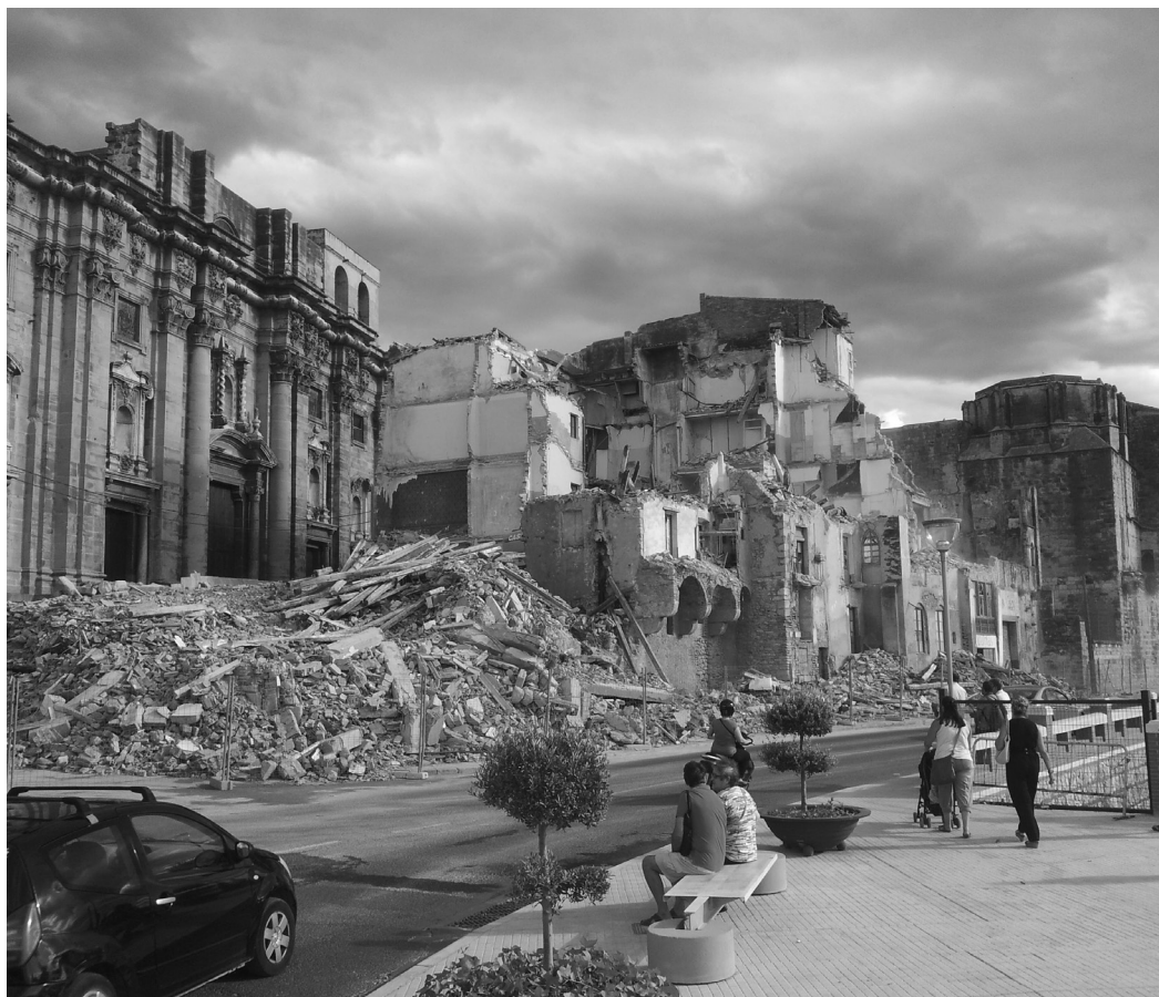
Derribo de parte de la fachada fluvial de Tortosa. Año 2015.
