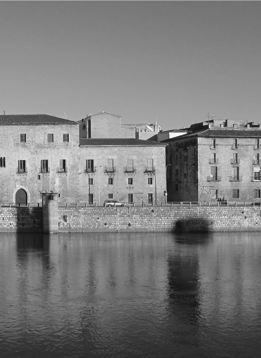
Vista de parte de la fachada fluvial de Tortosa. Año 2011.
