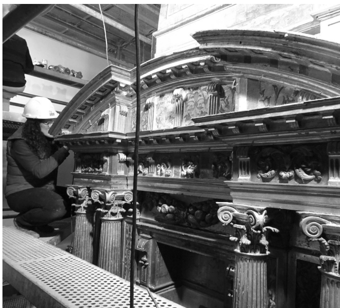
Trabajos de restauración del retablo - baldaquino.
