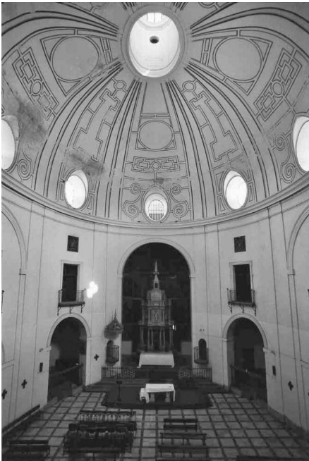
Vista general de la iglesia. Estado previo.
