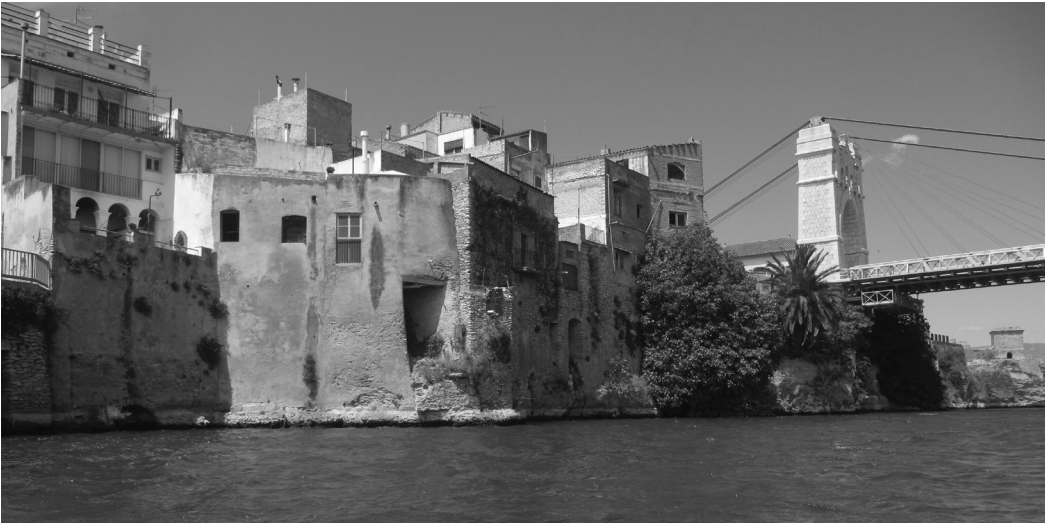
Vista de parte de la fachada fluvial de Amposta. Año 2012.
