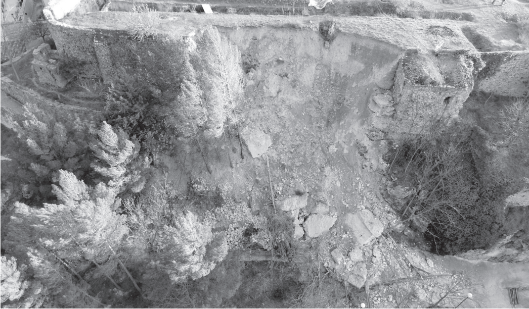
Aspecto de los derrumbes (S. Varela Botella).
