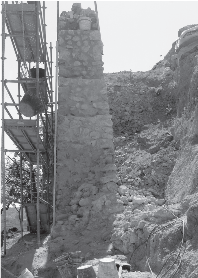
Sección del terreno y la muralla en el tramo de levante (S. Varela Botella).
