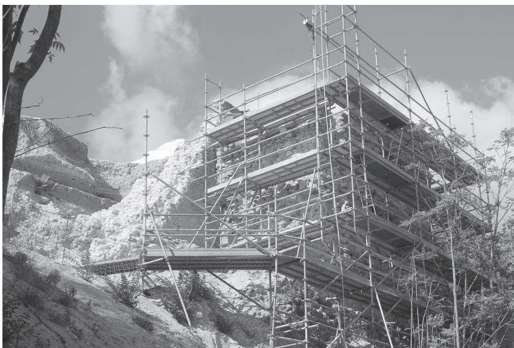
Tramo de puente con la torre adosada (S. Varela Botella).
