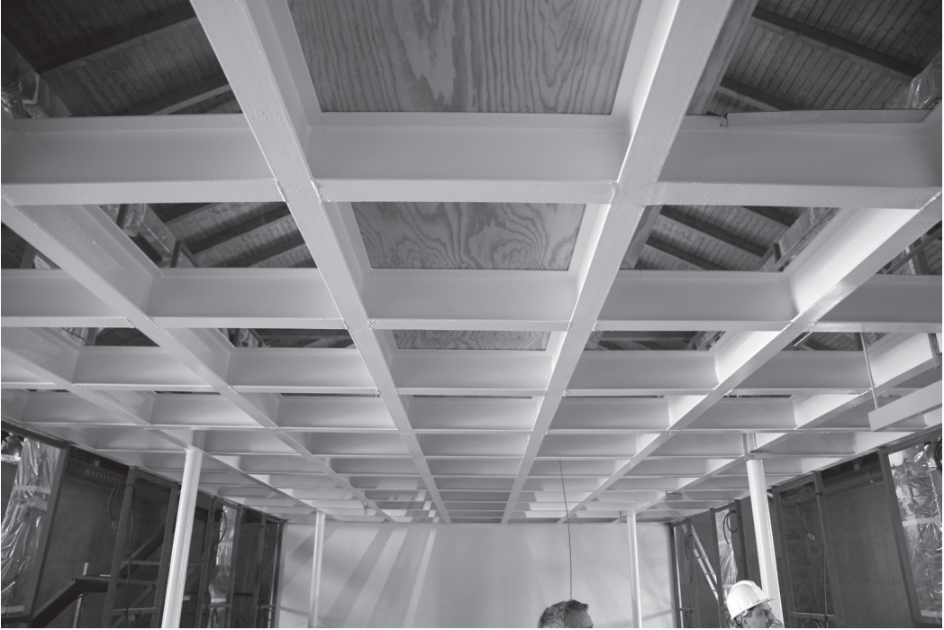
Vista de la planta baja hacia el entramado modular metálico. Autonomía sobre los pies derechos.
