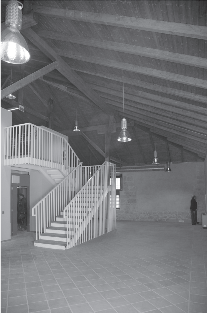
Escalera de doble tramo en la cabecera del almacén II.
