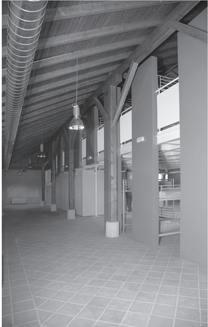
Espacio lateral del almacén II con los dormitorios en la cruja central de la estructura de madera.
