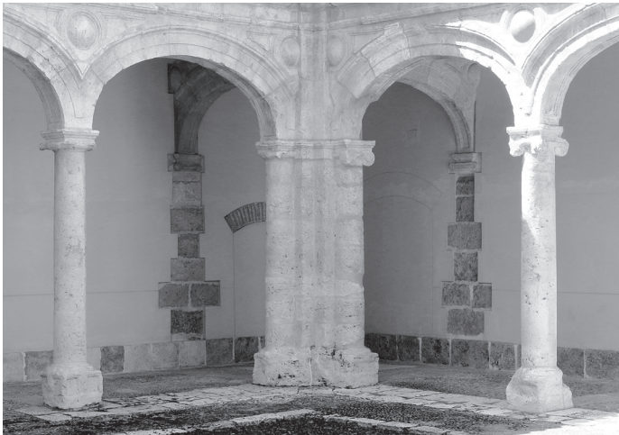
Figura 8. Mortero monocapa y elementos estructurales vistos, 2008 (J. L. Quintana Gordon).
