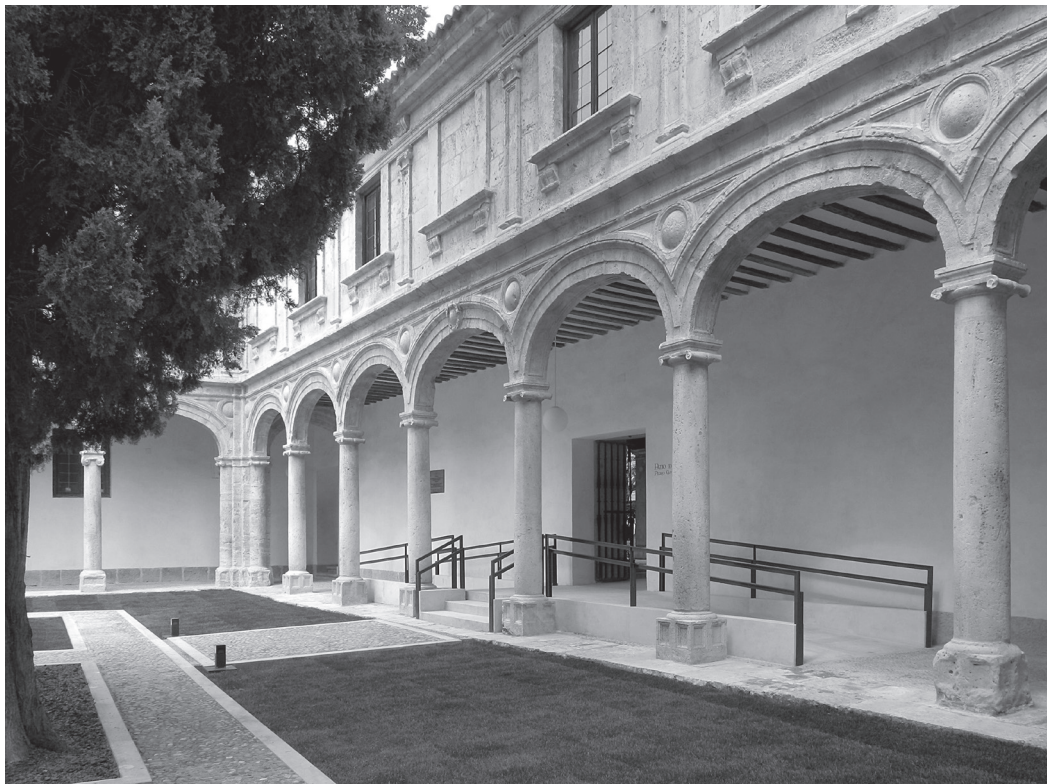
Figura 15. Nuevas rampas accesibles, con los rodapiés de piedra enrasados con los zócalos de la galería (J.L. Quintana Gordon).
