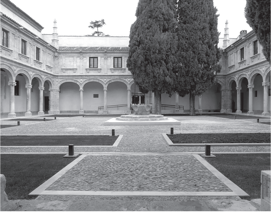
Figura 17. Solado y parterres recuperados. En primer término, paso desde las galerías al centro del patio, 2018 (J.L. Quintana Gordon).
