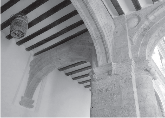
Figura 9. Revoco liso lavado con rebajes para resolver el desfase entre los arcos de esquina del siglo XVI y los sectores de muro reconstruidos en la Posguerra, 2016 (J. L. Quintana Gordon).
