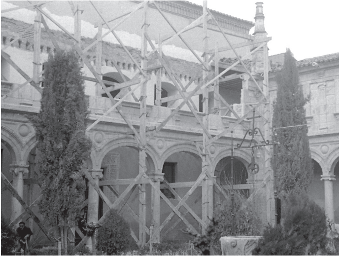
Figura 6. Obras de reconstrucción por anastilosis de la panda oeste, c. 1958 (Archivo González-Valcárcel).
