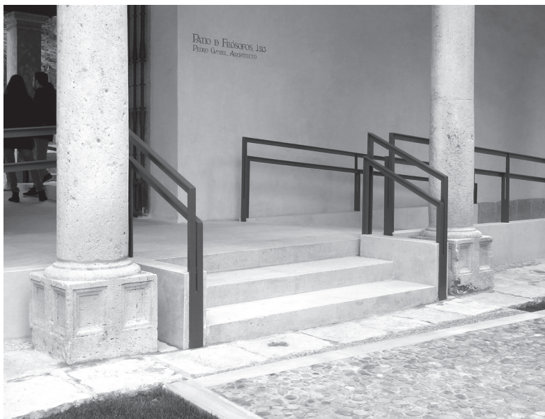
Figura 16. Acera exterior con las baldosas calizas recuperadas, 2018 (J.L. Quintana Gordon).
