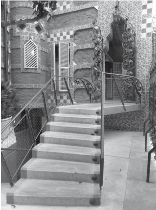
Casa Vicens. La nueva escalera de acceso al vestíbulo (Arxiu GMN, 04.01.2018).
