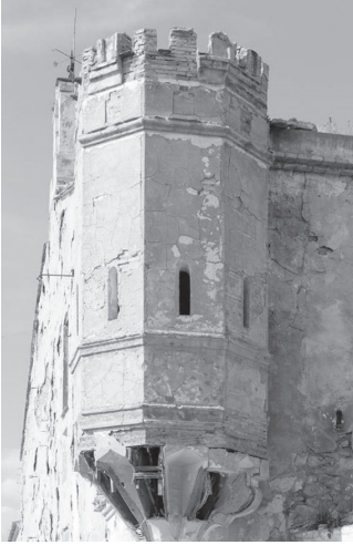
Garitón de esquina en la Casa de Camp, Llíria (J. Bonastre Pina).
