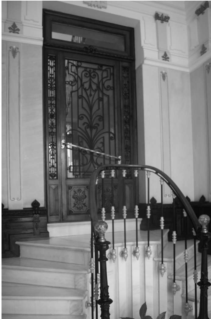
Página siguiente: Casa para D. Guillermo Campos, dibujo del plano y detalle de la puerta de acceso (Archivo Histórico Municipal de Alicante, legajo 48, sin número).
