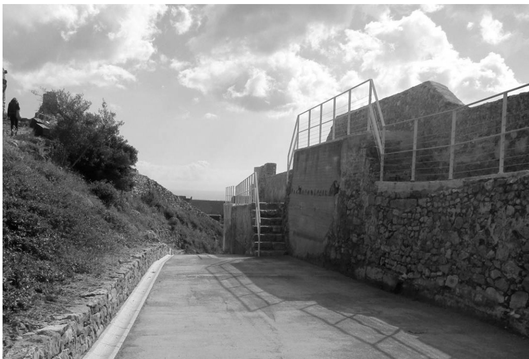
Cara interior de la zona oeste de la plaza de San Fernando: antes y después de la intervención con incorporación de barandillas para hacer factible la visitabilidad del adarve.
