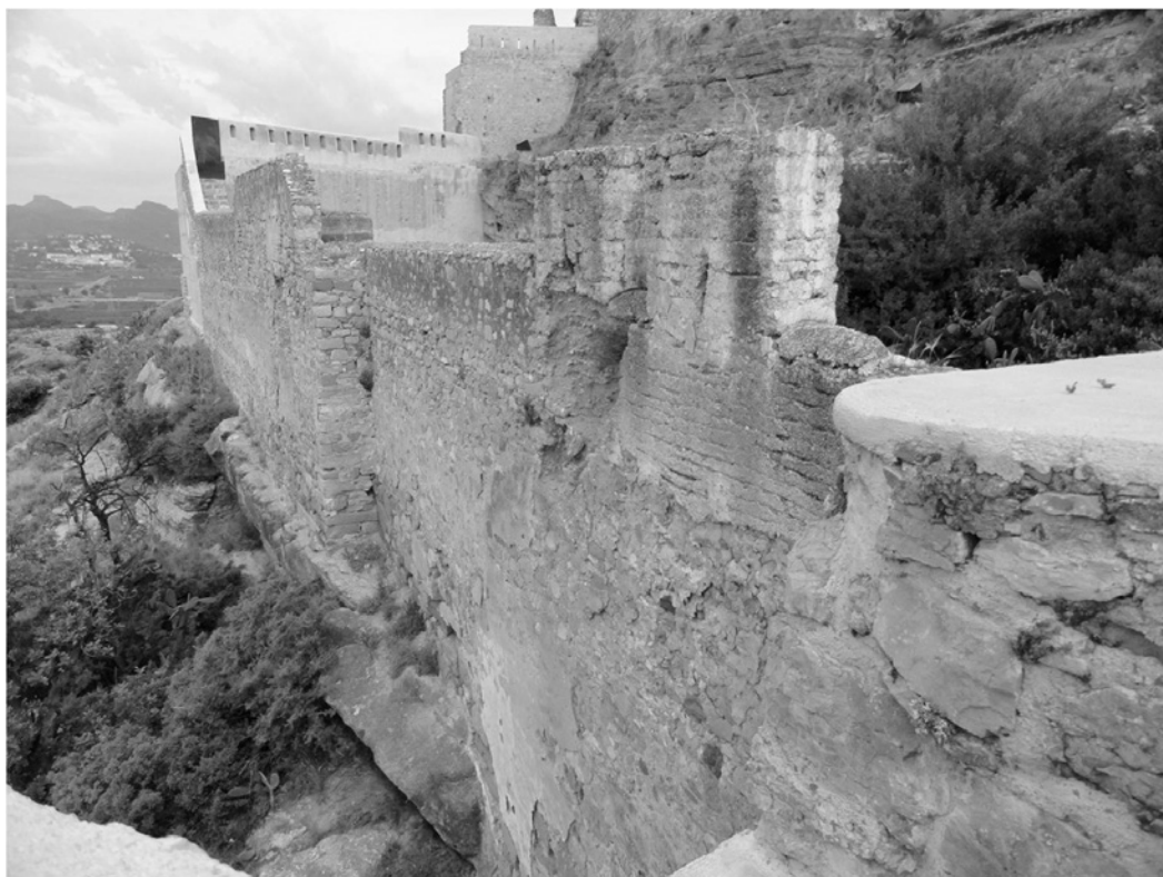
Cara exterior del lienzo de la zona oeste de la plaza de San Fernando: antes y después de la intervención con recuperación de un merlón con aspillera (esta página y siguiente).
