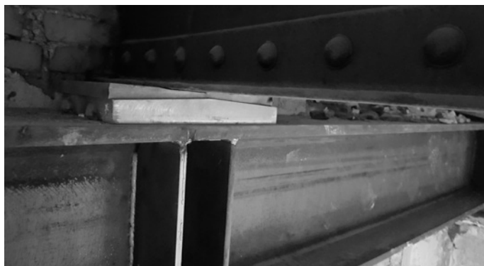
Vista del mecanismo de acuñado de las vigas roblonadas contra la viga de refuerzo (Foto Servicio de Arquitectura, Diputación Foral de Álava).
